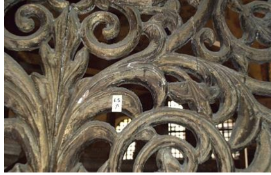
Resim 5.19. 6Nolu şebeke ayrılma (örnek 6.5.)
