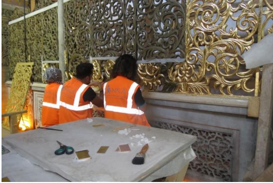
Resim 5.235. Miksiyon ve transfer varak uygulama
