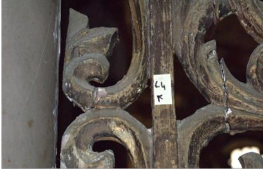
Resim 5.18. 6Nolu şebeke ayrılma (örnek 6.4.)
