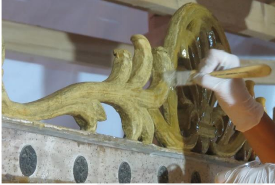
Resim 5.233. Varak altı miksiyon işlemi
