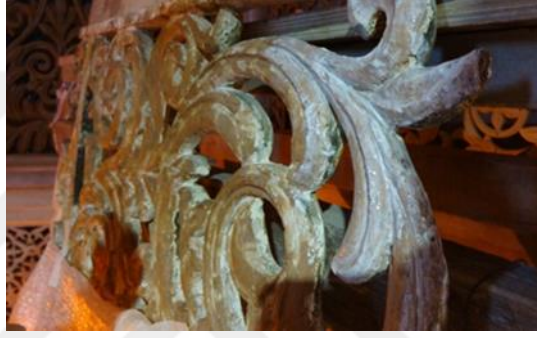
Resim 5.218. Hazırlık tabakası uygulama
