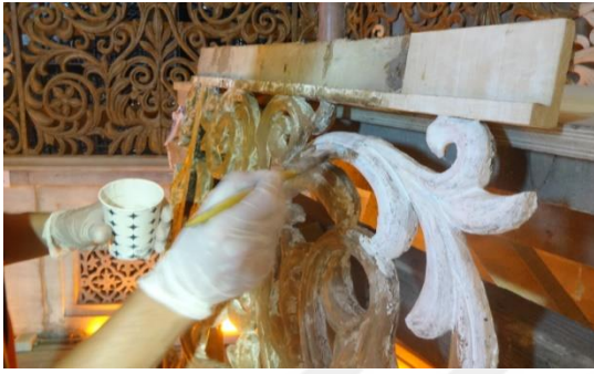
Resim 5.217. Hazırlık tabakası uygulama
