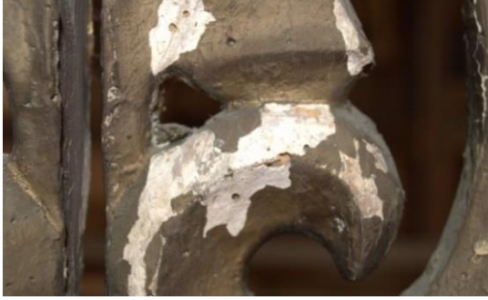
Resim 5.50. 2Nolu şebeke yüzeyden ayrılma
