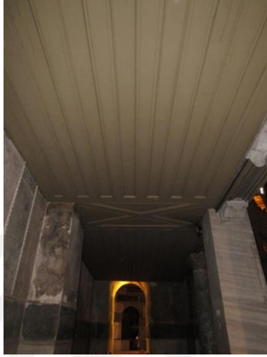
Resim 4.13. Mahfil döşeme alt görünüş
