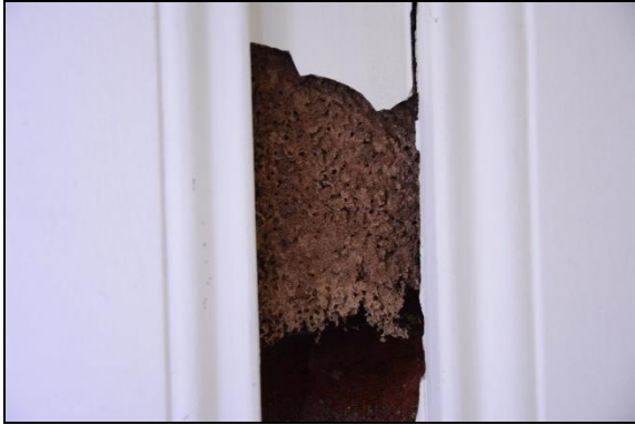
Resim 5.39. Yoğun galeri içeren, çürümüş ahşap
