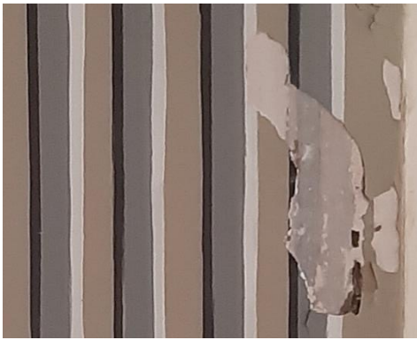
Resim 5.45. Sütun taklidi, zayıf özgün katmanlar
