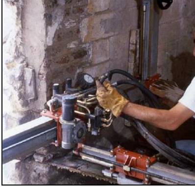
Resim 5.8. Duvarın kesilmesi işlemi
