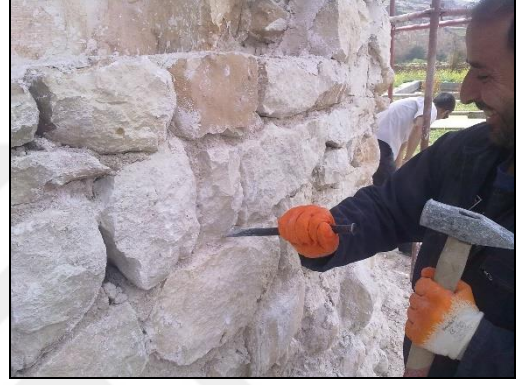
Resim 5.22. El aletleri ile çimento raspa işlemi
