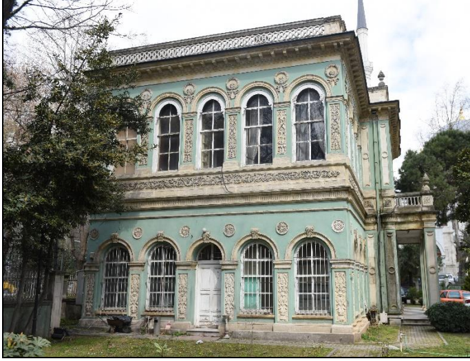
Resim 2.12. Tophane Kasrı güneybatı cephesi
