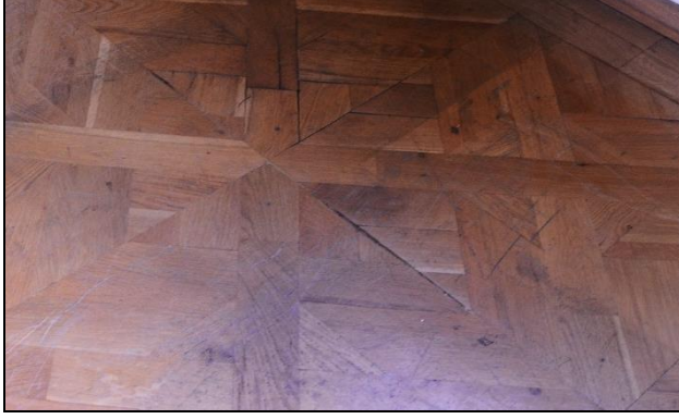
Resim 5.40. Boşalmış derzler ve kararmaya başlamış vernik
