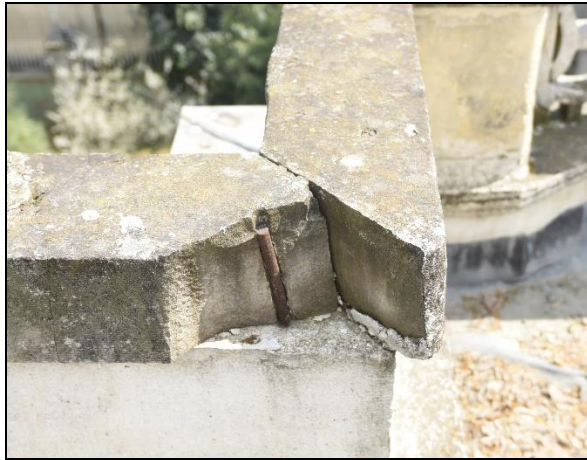
Resim 5.26. Parça kopmasına neden olan donatılar
