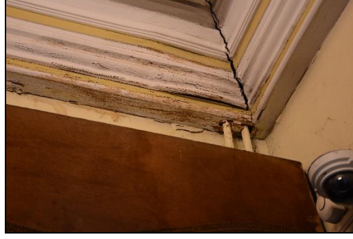
Resim 5.38. Sunta tavan silmesi
