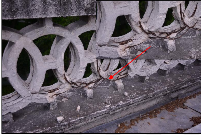
Resim 5.25. Parça kopmasına ve ayrışmalara neden olan donatılar
