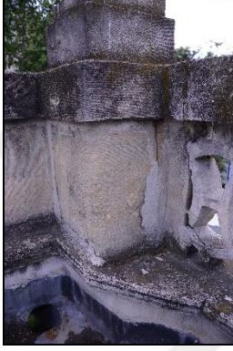
Resim 5.21. Parapette yapılmış çimentolu onarım
