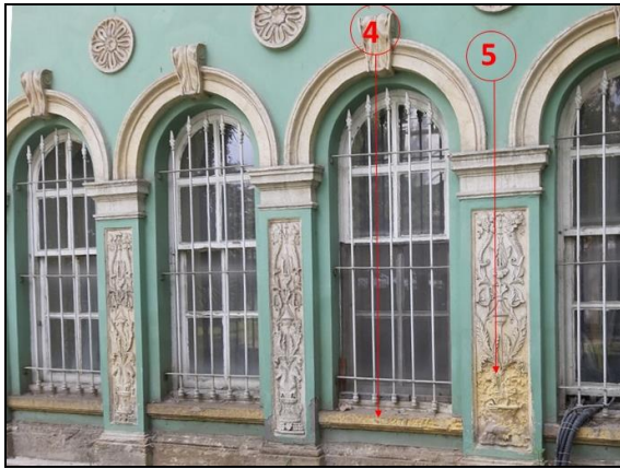
Resim 5.13. Tuz testi için yan cepheden örnek alınan yerler
