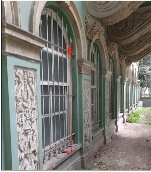
Resim 5.14. Tuz testi için arka cepheden örnek alınan yerler
