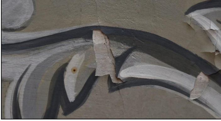
Resim 4.11. Birinci kat duvarından özgünün üstüne yapılan yeni kalemışı örneği
