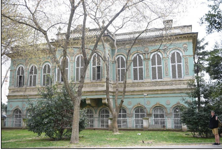
Resim 2.10. Tophane Kasrı arka cephesi
