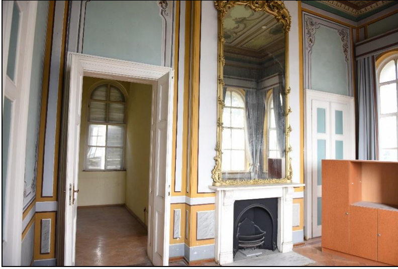
Resim 2.24. Kuzeydoğudaki odanın duvarı
