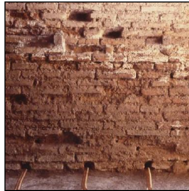
Resim 5.7. Tahliye için yerleştirilmiş bakır borular
