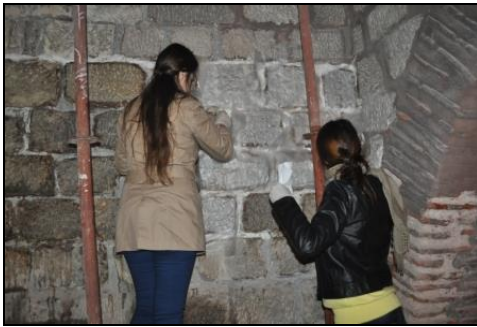
Resim 5.23. Kâğıt hamuru ile tuz ekstraksiyonu
