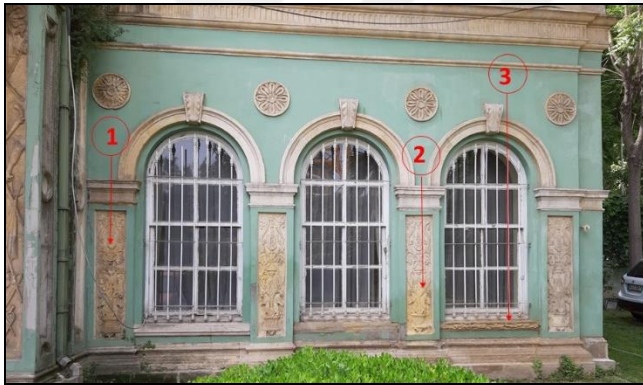
Resim 5.12. Tuz testi için ön cepheden örnek alınan yerler
