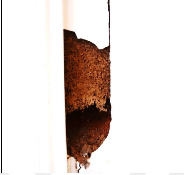
Resim 4.2. Mantar ve böcek istilasına uğramış ahşap
