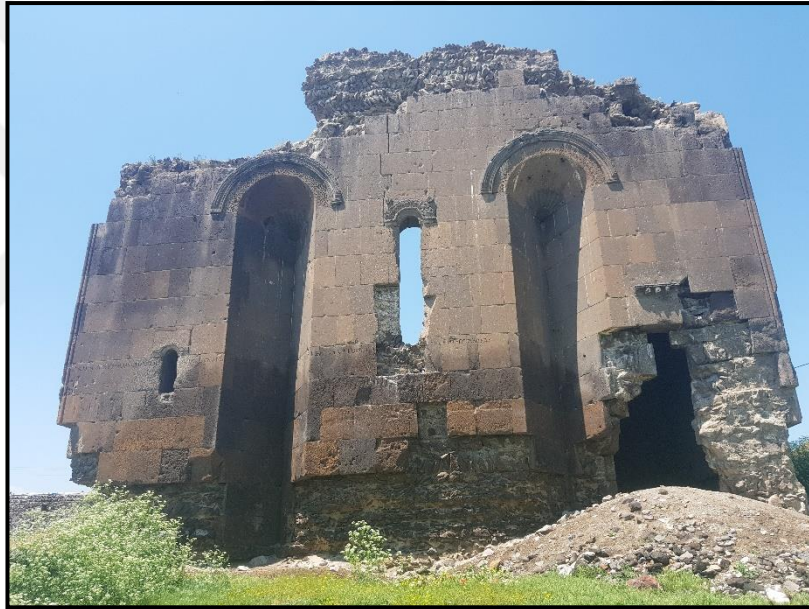
Fotoğraf 4.28. Oğuzlu Köyü Kilisesi'nden Bir Görünüm (30.06.2018).
