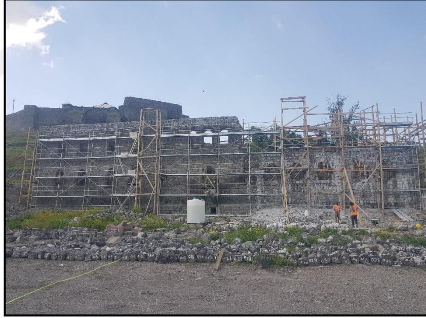
Fotoğraf 4.50. Restorasyon Sürecindeki Beylerbeyi Sarayı'ndan Bir Görünüm (26.06.2018).
