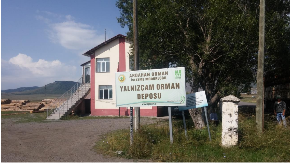
Fotoğraf 3.11. Yalnızçam Köyü'nde Bulunan Yalnızçam Orman Deposu
