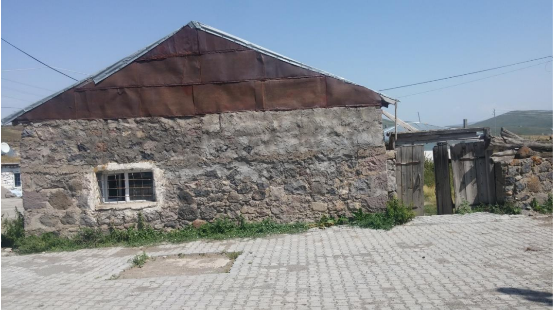
Fotoğraf 2.22. Üstü Saç Çatı İle Örtülmüş Geleneksel Köy Konutu (Çatalköprü Köyü)
