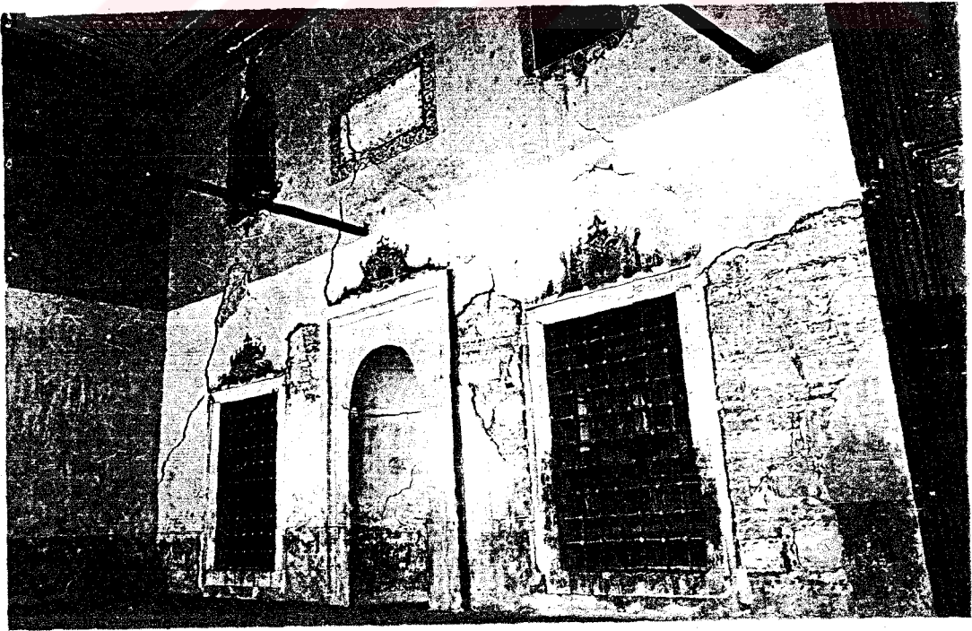
Foto. 52- II. Sultan Murat Camii Son Cemaat yeri duvar yüzeyinin genel görünüşü
