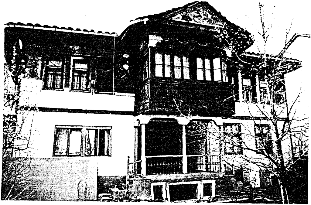
Foto. 167- Cafer Efendi Konağı güney cephesi
