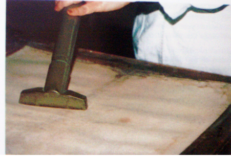
Resim 28: Elektrik süpürgesi ile yapılan temizlik çalışması
