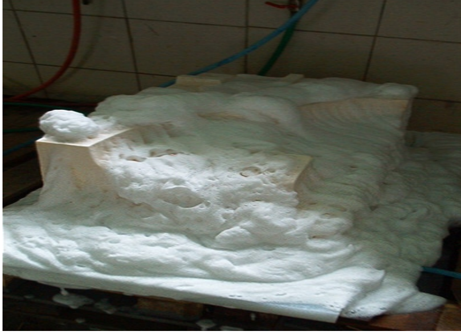
Fotoğraf 96: Dökülen kalıba hava ve su verilmesi
