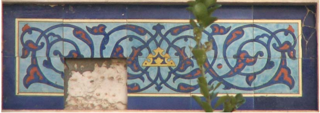
Fotograf 6: Milli Kütüphane Binası, Cephe 1, giriş kapısı sol tarafında bulunan pano
