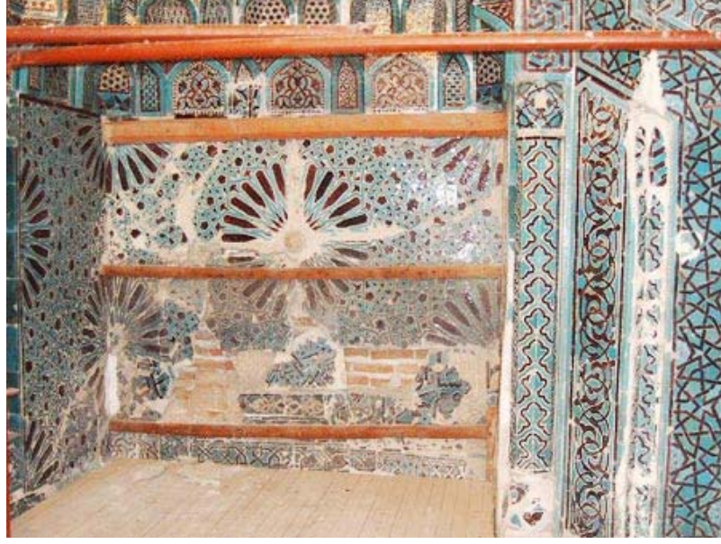
Fotoğraf 5: Akşehir Taş Medresesi Mihrabı, 2004 – 2005, onarım öncesi
