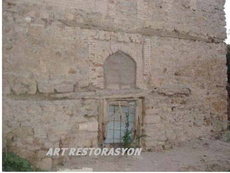
Fotoğraf 23: Akşehir Küçük Ayasofya Mescidi, 2006, onarım öncesi
