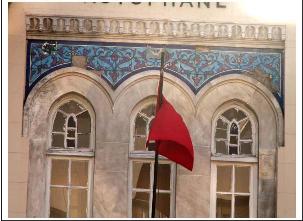
Fotograf 7: Milli Kütüphane Binası, giriş kapısı üstü pencere alınlığı
