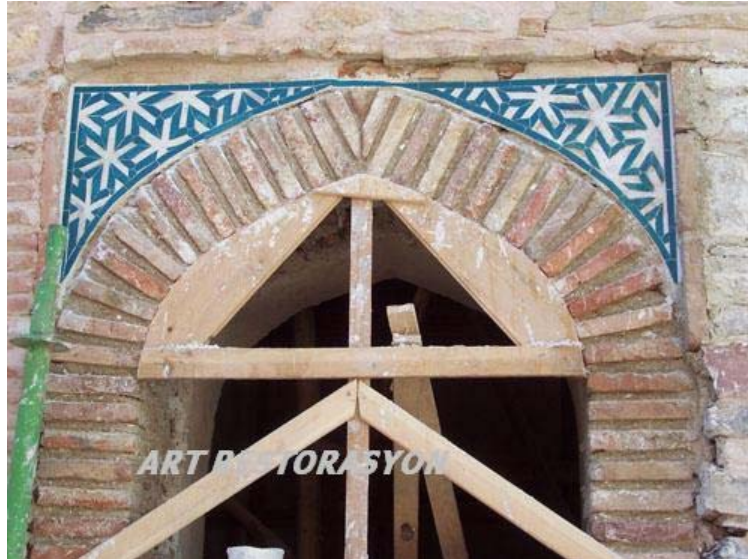
Fotoğraf 24: Akşehir Küçük Ayasofya Mescidi, 2006, onarım sonrası
