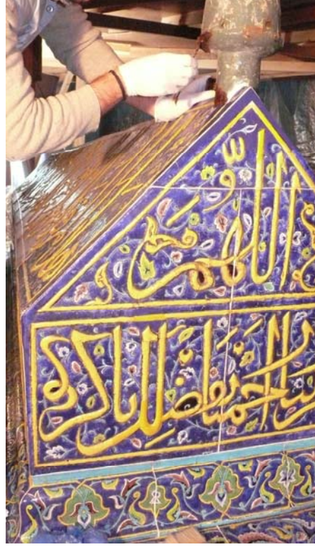
Fotoğraf 1: Bursa Yeşil Türbe, 2006 – 2008 onarım aşaması
