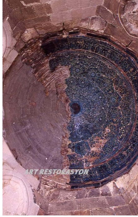
Fotoğraf 3: Beyşehir Eşrefoğlu Camii Mozaik Çinileri, 2004 – 2005, onarım öncesi
