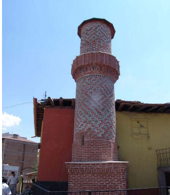
Fotoğraf 16: Aksaray Kesik Minare, 2005, onarım sonrası
