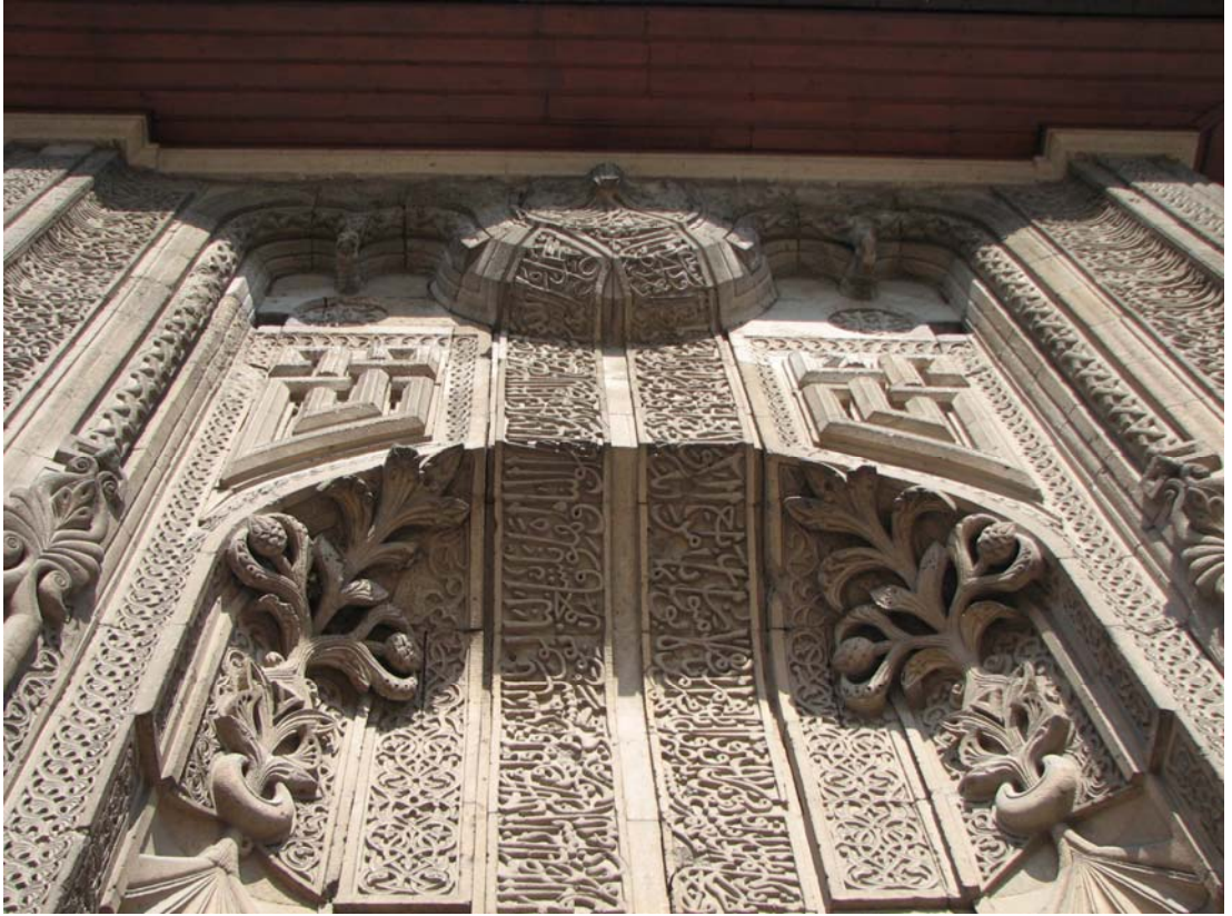
Resim 39: "Taçkapı, Konya İnce Minareli Medrese".
