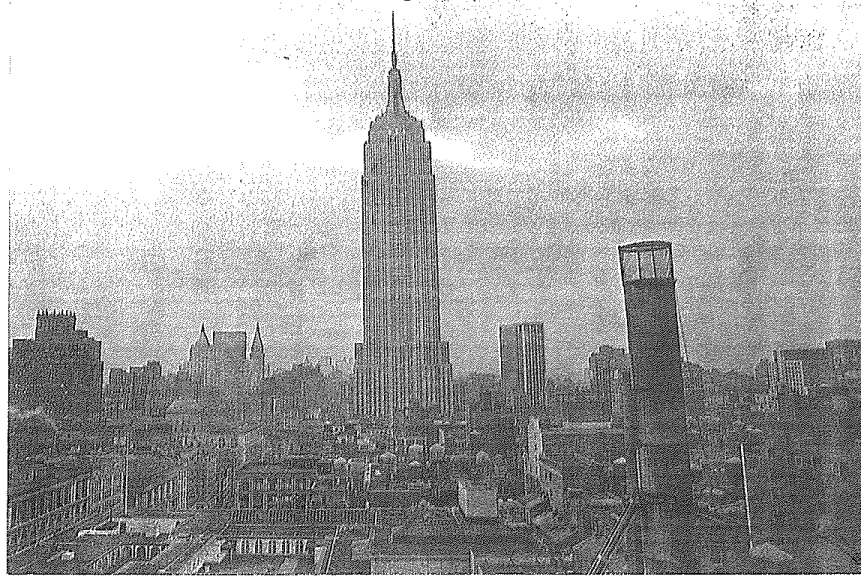
Resim 5. Empire State Binası, New York, 1929-31
