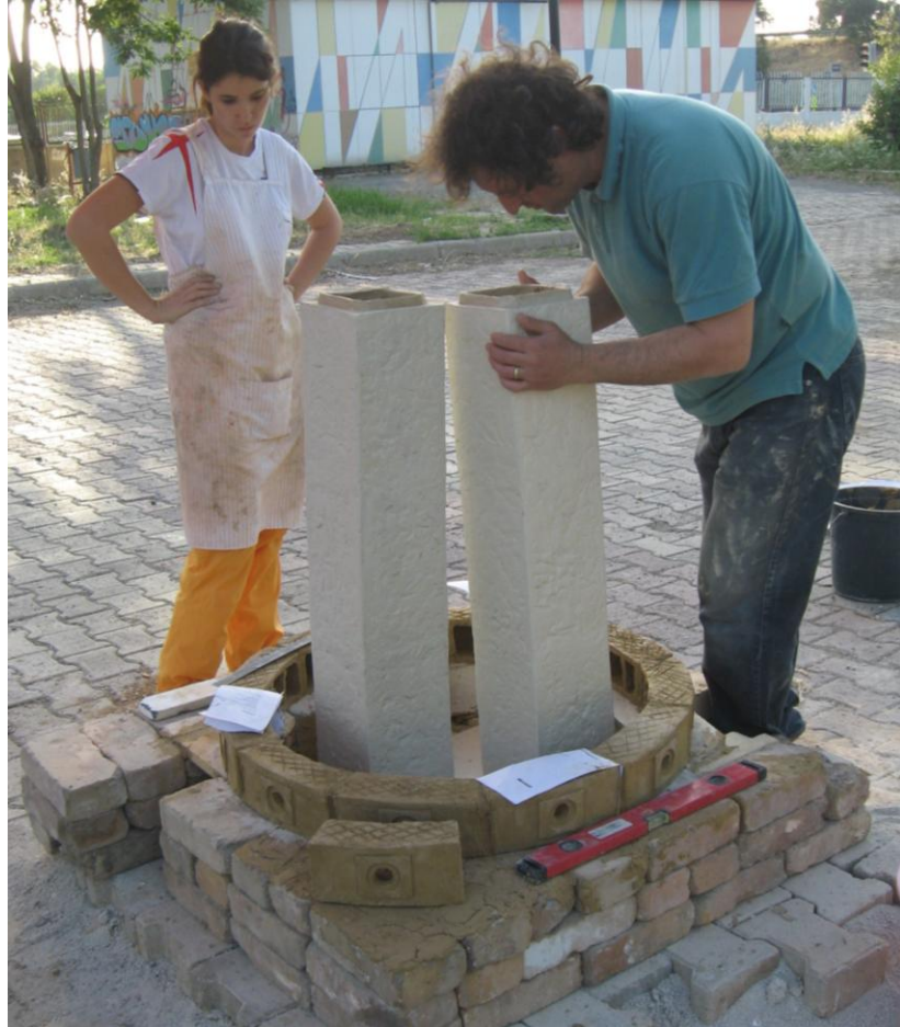
Fotoğraf 90, 91 Sırasıyla, fırın heykelin ilk sırasının dizilmesi ve içinde pişirilecek heykelin yerleştirilmesi.
