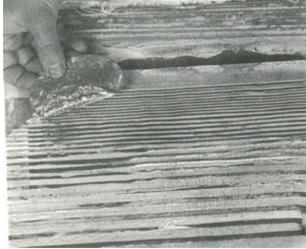
Resim 93-izgili řeritler astar ile birbirine kaynařtırılır.
