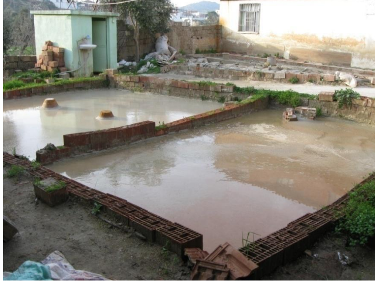
Fotoğraf 77: Çamur çöktürme havuzları
