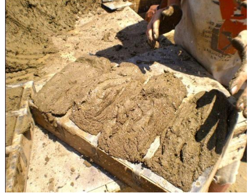
Fotoğraf 34: Çamur dolu kalıp
