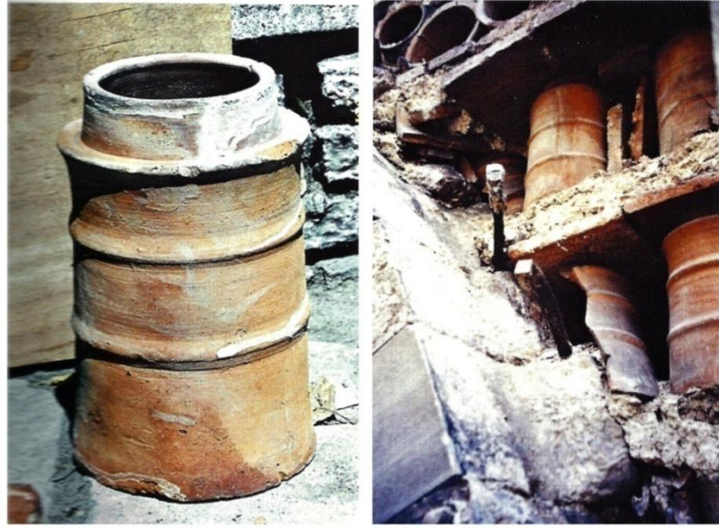
Fotoğraf 15: Edirne II. Bayezid Camisi'nin temellerinden çıkan künkler ( Fotoğraf, Hüsrev Tayla, a.g.e )
