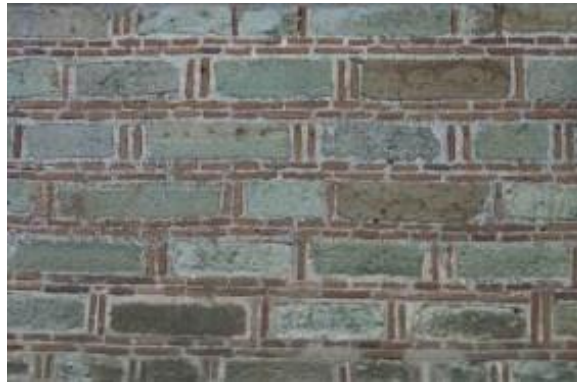
Fotoğraf 7: Almaşık duvar Yapısına Örnek
