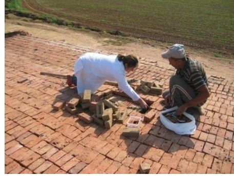
Fotoğraf 40: Plakaların yerleştirilmesi
