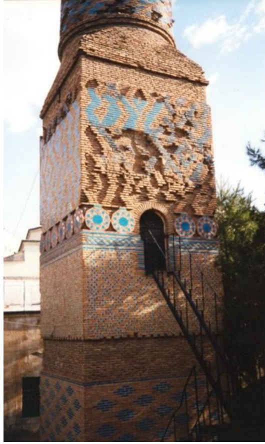
Fotoğraf 4: Siirt Ulu Cami Minaresi(1129) Sırlı ve Sırsız Tuğla Örnekleri
