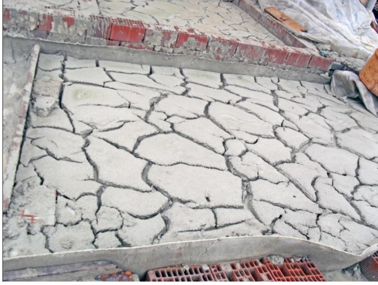
Fotoğraf 78: Çamur çöktürme havuzunda suyun çektilmiş hali
