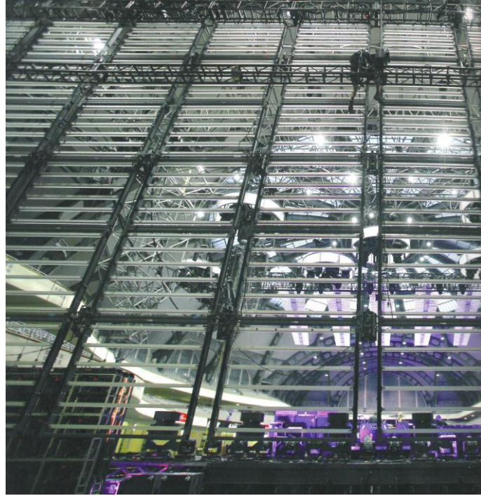
Şekil-176: Truss konstrüksiyon uygulaması
