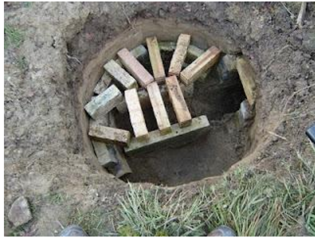
Resim 7-Tuğla destekli üstten çekişli Roma fırını
