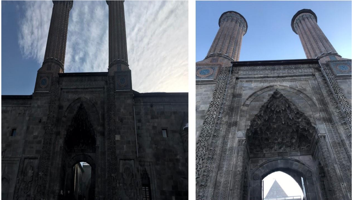
Resim 2.29. Çifte Minareli Medrese Dış Cephesi
