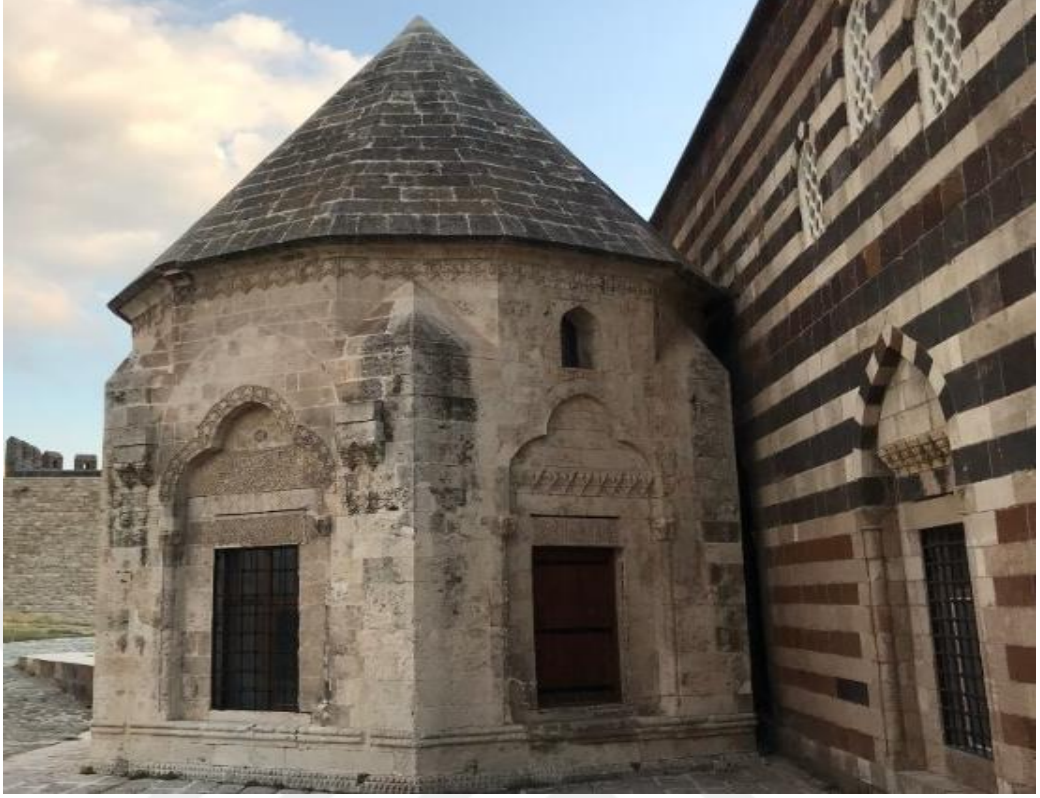
Resim 4.15. Hüsrev Paşa Türbesi
