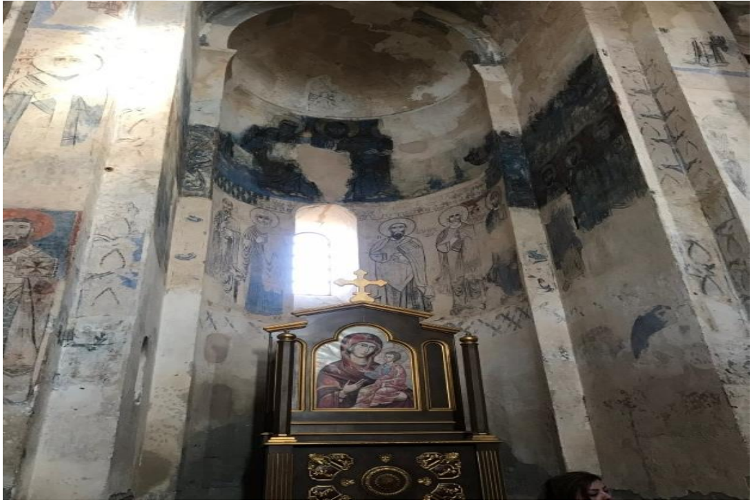
Resim 4.11. Akdamar Kilisesi İç Mekânı
