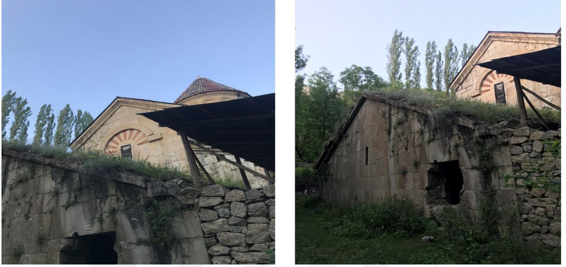
Resim 2.36. Manastırın Batı Cephesi
