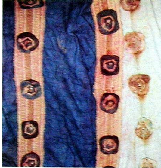
Fotoğraf 39: Kolanlar çadırın iskeletidir. Mimaride yapıyı taşıyan elemanların yerini çadırda kolanlar almıştır. Bütün bağlantılar, germeler kolanlar üzerinden yapılır. Üzerlerine dikilmiş kösele parçaları kuvvetli olan kolanları daha da güçlendirir.
