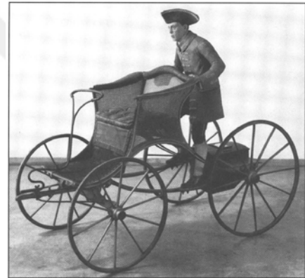
Görsel 2: Gravür (Kas gücü ile ilerleyen pedallı araba, 1765. Yine arka aks yönlendirmeli. ), Eckerman, 2001, introduction, ix,x
