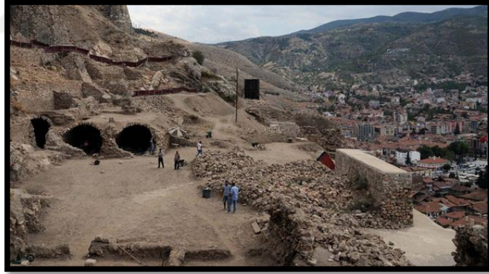
Foto.: 191 Tokat Kalesi Onarımı Yapılan Kısım
