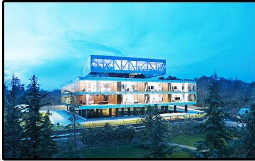
Şekil 77- Vakko Moda Merkezi Binasi, Nakkaştepe/İstanbul
