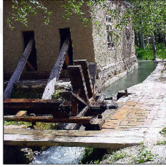
Resim 29: Semerkand yakınında 19. yüzyıldan kalma ve tokmakları su çarkı ile çalışan bir kâğıthanenin genel görünümü.
