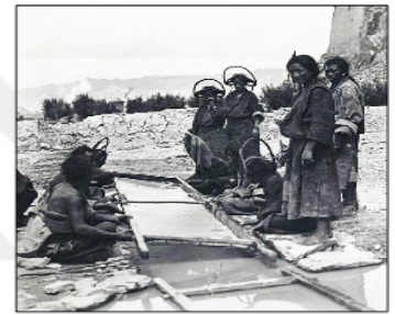
Resim 26: Keşmir'de kâğıt yapımı (1917). Kâğıt tabakalarının duvar üzerinde kurutulması.
