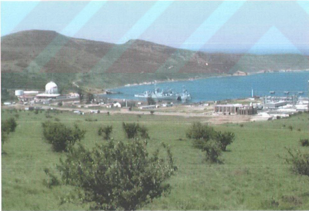
Foto 12: Karaağaç Koyu'ndaki Ege Gaz Dolum tesisleri.
