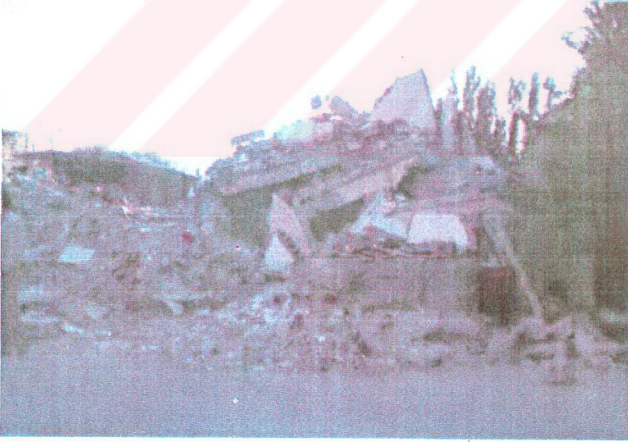
Foto 2: Hasarın Çok Olduđu Alüvyal Zeminde Bulunan Yapılar.
