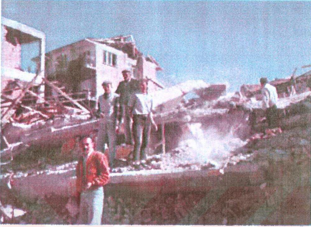
Foto 3: Hasarın Çok Olduđu Alüvyal Zeminde Bulunan Yapılar.
