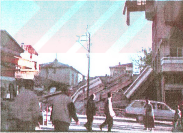
Foto 6: Yana Doğru Yıkılan Bir Yapı.
