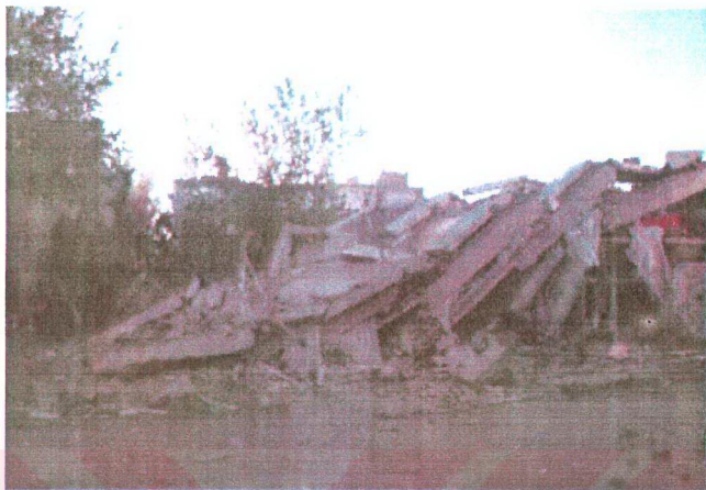
Foto 7: Yana Doğru Yıkılan Bir Yapı.
