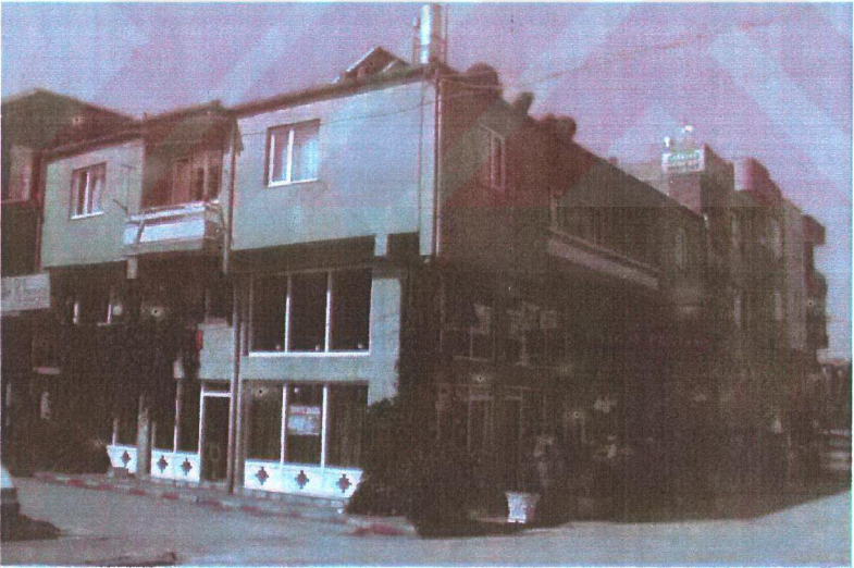
Foto 16: Eski Yerine Yapılmış Bir Yapı.
