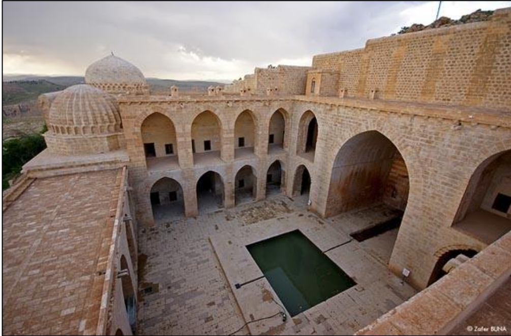
Sultan Kasım Medrese'nin Avlusu
