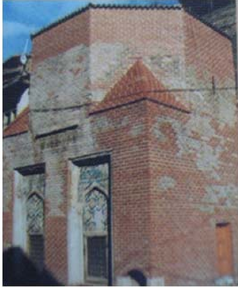
Fotoğraf 79: Ebu'l Kasım Türbesi (Ali Tusi Türbesi 1234)
