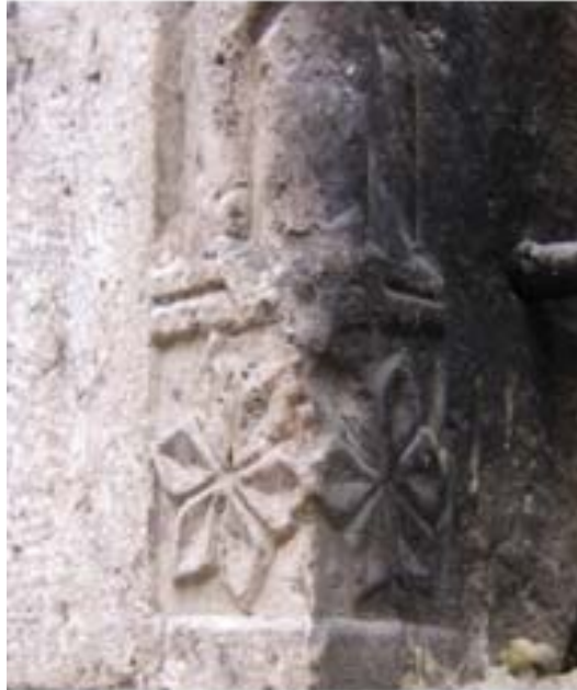
Fotoğraf 67: Nureddin İbn-i Esentimur Türbesi'nin Kuzey-Güney Cephesindeki Pencere Köşelerinde Yer Alan Sütunce Kaidesi Genel Görünümü
