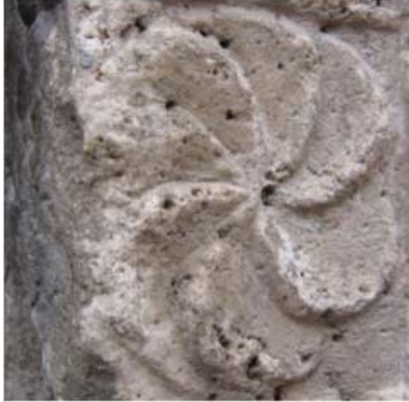
Fotoğraf 69: Nureddin İbn-i Esentimur Türbesi'nin Kuzey-Güney Cephesindeki Pencere Köşelerinde Yer Alan Sütunce Kaidesinden Detay
