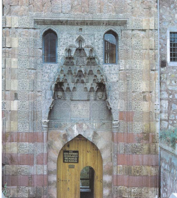
Fotoğraf 5: Gök Medrese Taçkapısı Restorasyon Sonrası Genel Görünümü
