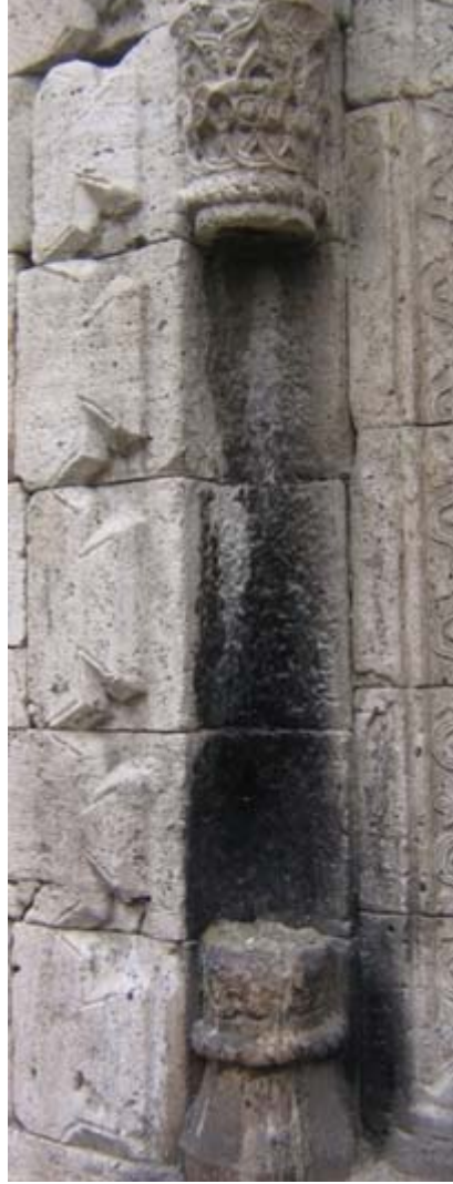
Fotoğraf 76: Nureddin İbn-i Esentimur Türbesi'nin Doğu Cephesinde Yer Alan Pencere Dış Sütunce Düzenlemesi
