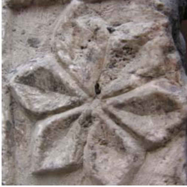
Fotoğraf 68: Nureddin İbn-i Esentimur Türbesi'nin Kuzey-Güney Cephesindeki Pencere Köşelerinde Yer Alan Sütunce Kaidesinden Detay
