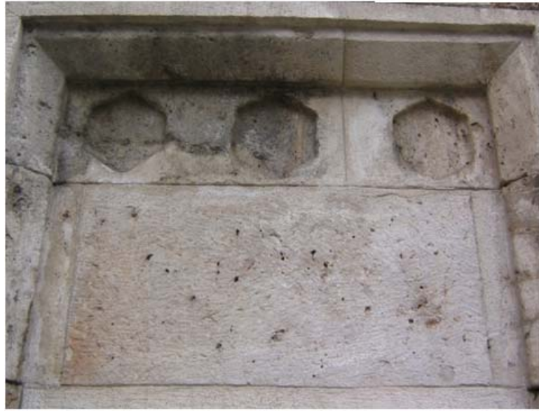
Fotoğraf 61: Sünbül Baba Zaviyesi'nin Kuzey-Doğu Cephesinde Yer Alan Türbenin Pencere Alınlığı
