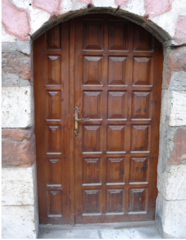
Fotoğraf 64: Nureddin İbn-i Esentimur Türbesi'nin Güney Cephesinde Yer Alan Giriş
