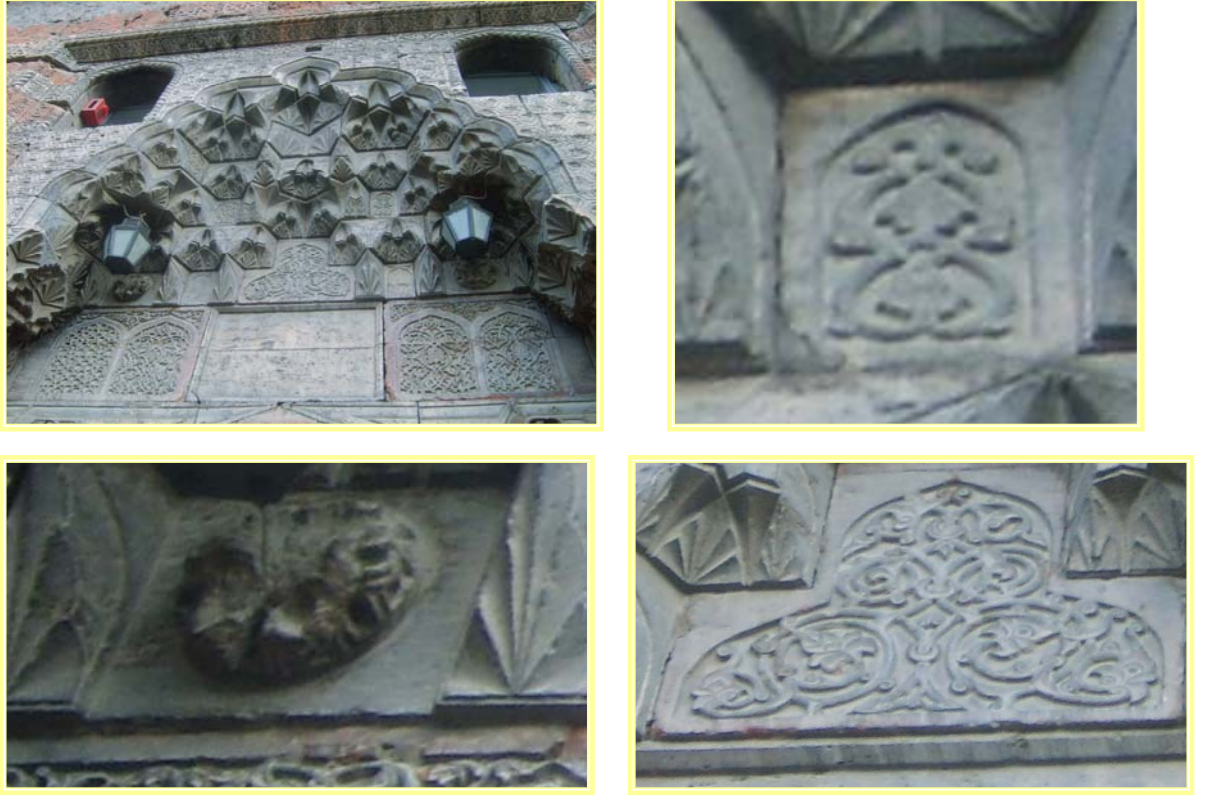
Fotoğraf 13: Gök Medrese Taçkapısı Genel Görünümü, Kabara, Dilimli Pano
