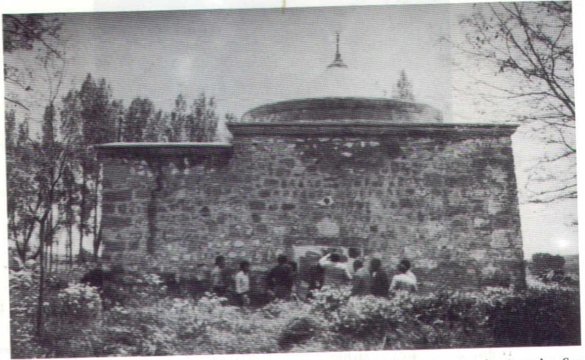
Bünyan Karakaya Köyü'nde Eratnalılar Devri'nden kalan ve sonradan onarılan Seyyid Halil ve oğlu Seyyid İsa'ya âit türbenin cepheden görünüşü.
