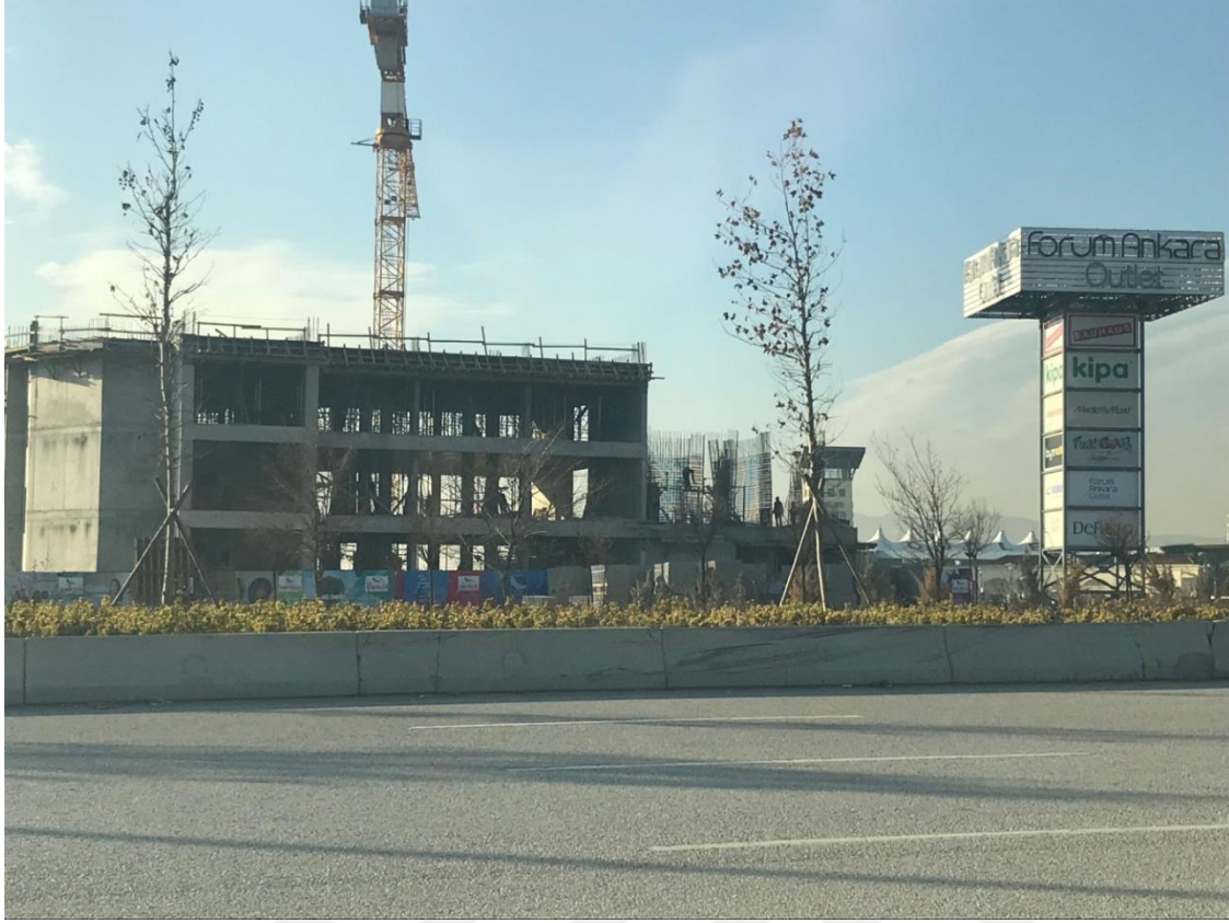
Resim 3.6. Forum Ankara Outlet ve Bitiřindeki Sınav Koleji İnřaatı (8 Aralık 2012)
