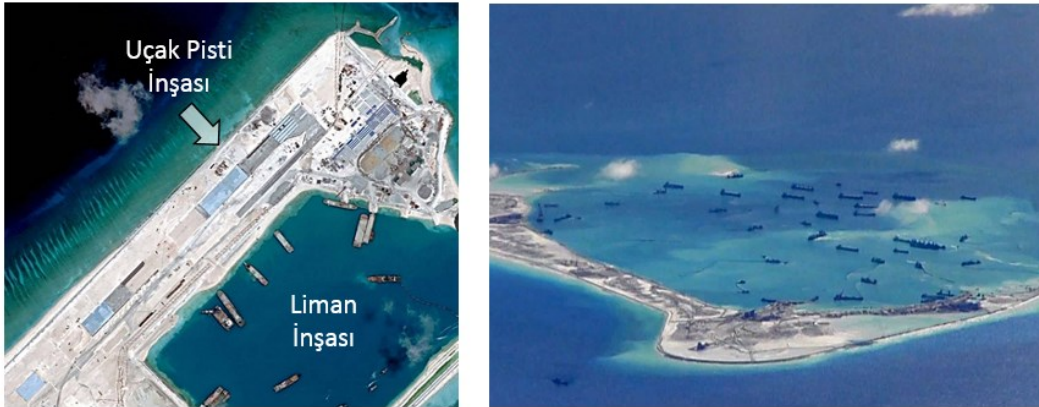
Resim 5.1.: Çin'in Spartly Adaları'ndaki Dolgu/İnşaat Çalışmaları (Kaynak: Binzat, 2015)
