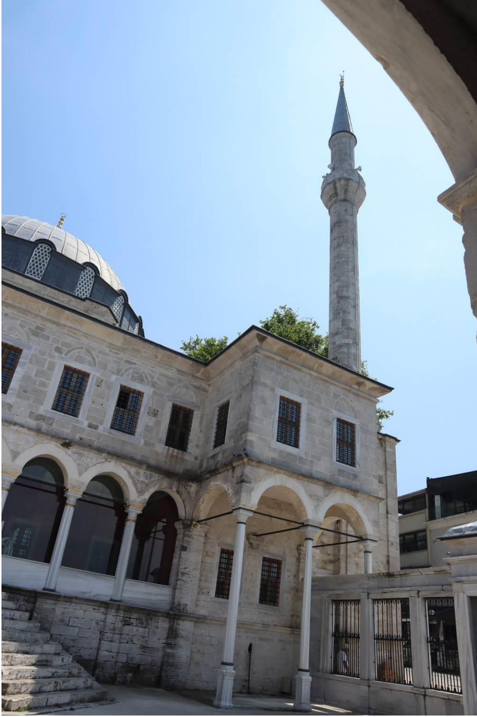
Resim 4.71. Beylerbeyi Cami iç avlu cephesi 2
