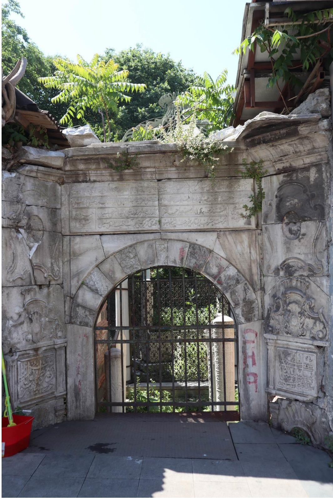
Resim 4.10. Koca Ragıp Paşa Külliyesi haziresine bakan pencere
