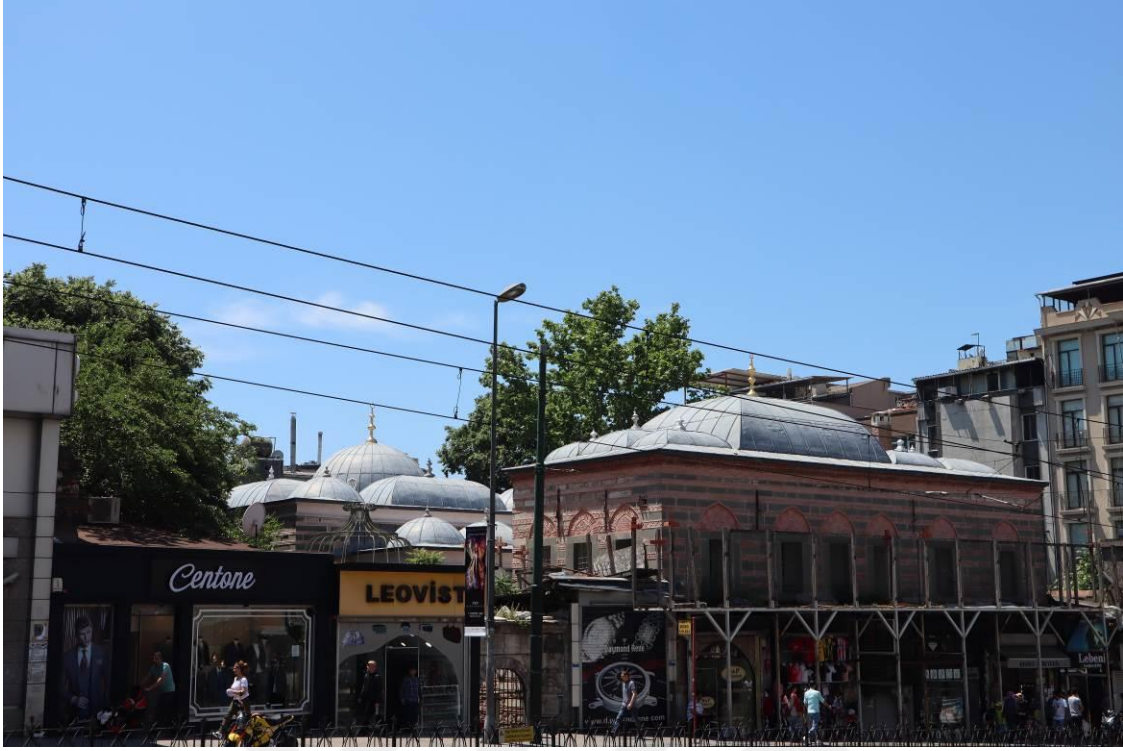
Resim 4.8. Koca Ragıp Paşa Külliyesi cephe görünümü
