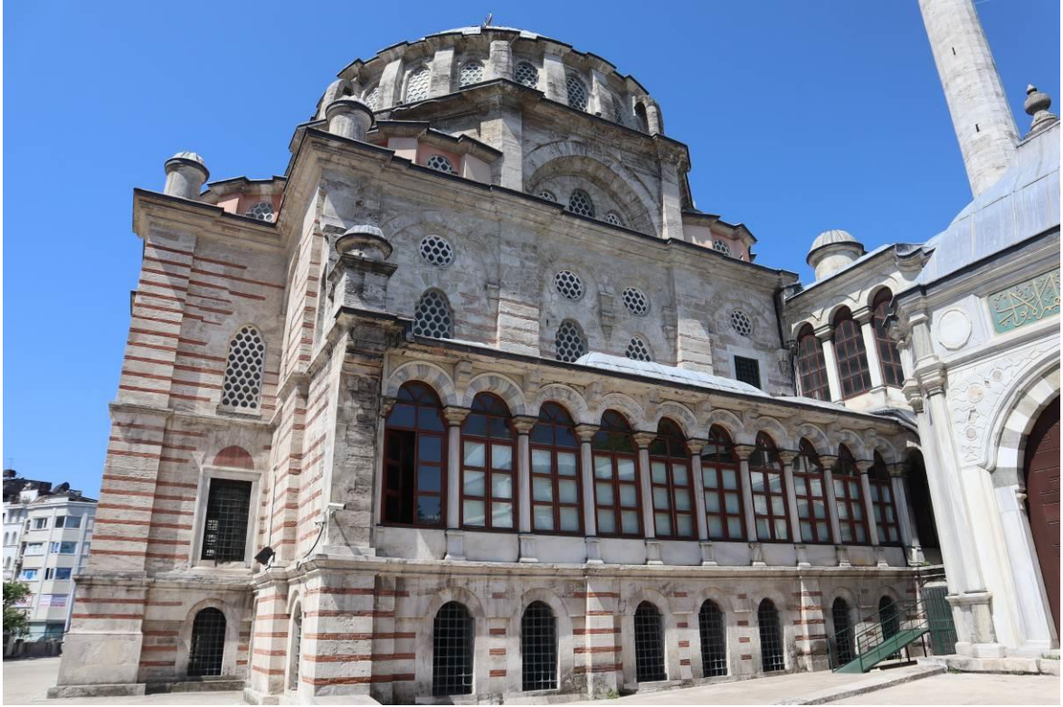
Resim 4.19. Laleli Cami revaklı cephe
