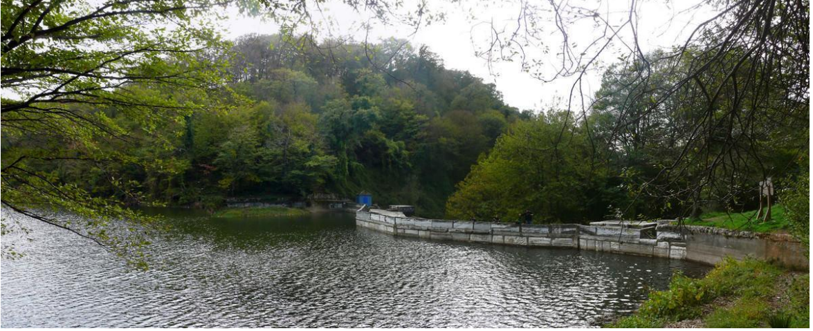
Resim 4.62. Ayvat Bendi dere tarafından görünüşü
