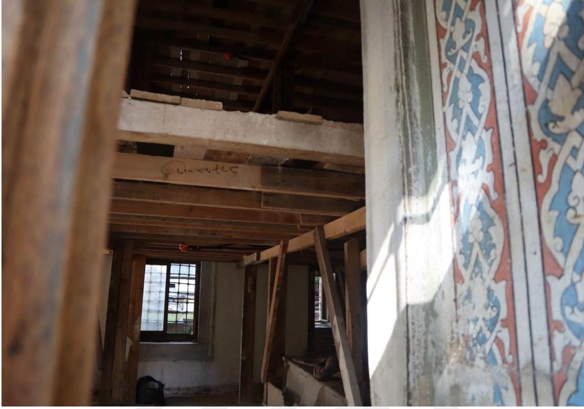
Resim 4.46. Zeynep Sultan Cami restorasyonundan görünüm
