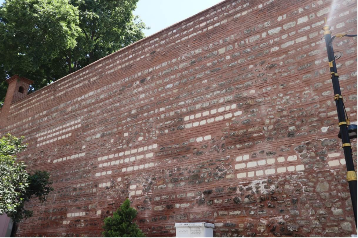
Resim 4.11. Koca Ragıp Paşa Külliyesi dış yan duvar görünümü
