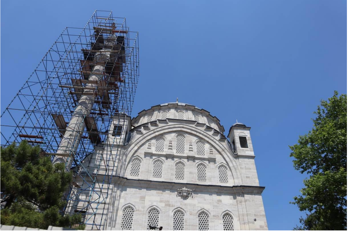
Resim 4.4. Ayazma Külliyesi restorasyonundan görünüm
