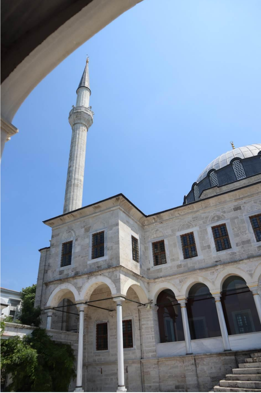
Resim 4.70. Beylerbeyi Cami iç avlu cephesi 1
