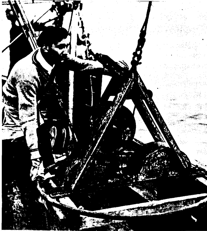
Şekil 22 : Holme'un iki kepçeli örnekleyicisi, indirilmeye hazır durumda.
