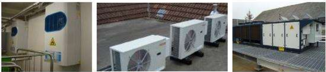
Resim 1: HC Soğutkan uygulamalarına örnek soğutma sistemleri
