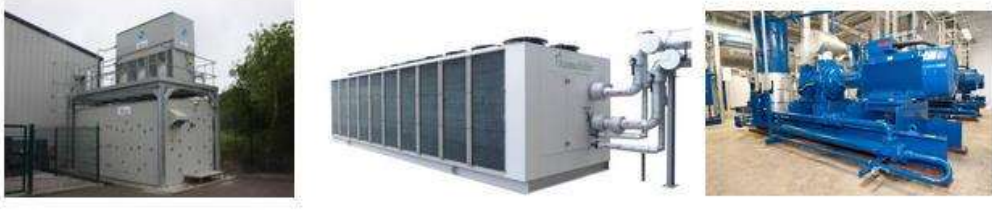
Resim 2: Amonyum soğutkanın kullanıldığı paket sistemlerden bazı örnekler (RealAlternatives, 2018).
