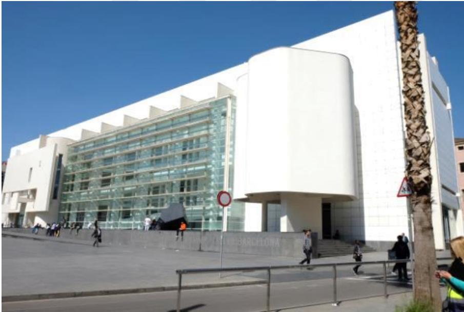
Şekil 4.10: Barselona Çağdaş Sanat Müzesi cephe görünüşü. Gamze Karayılanoğlu Arşivi, 2018.
