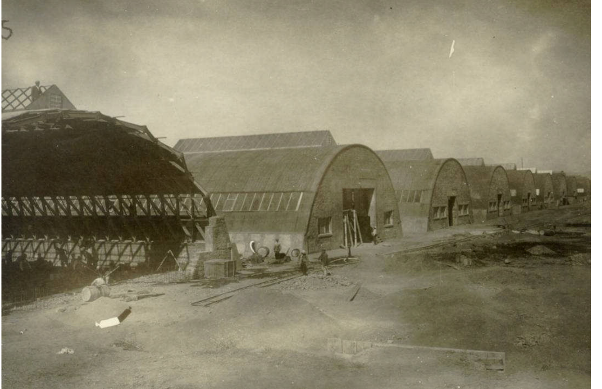
FOTOĞRAF 12: HANGAR İNŞAATI
