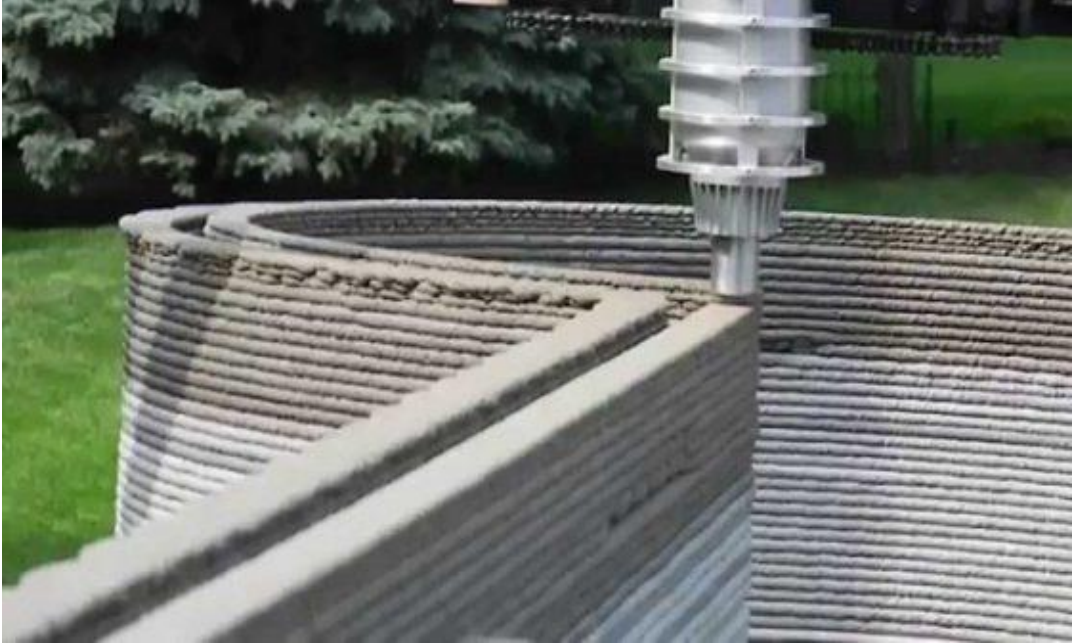
Fotoğraf 2.4. 3B yazıcının inşaat alanında kullanımı [11]
