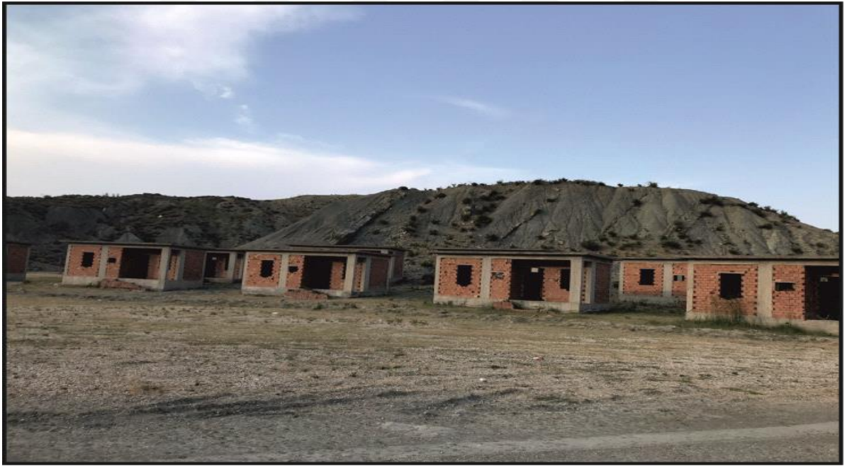
Şekil 4.6. Aslantaş formasyonunun genel görünümü (Kurtkulağı mevki, KB'dan GD'ya bakış).
