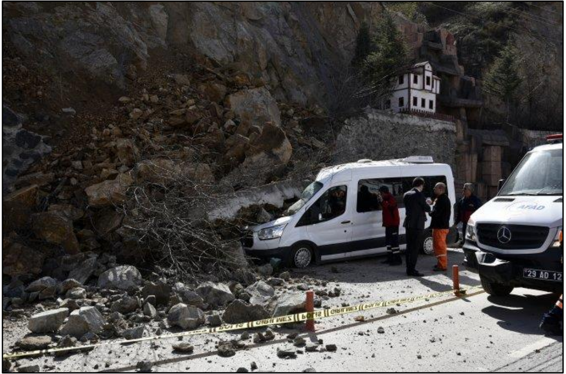
Şekil 3.13. Karayolu kenarındaki kesilmiş şevlerden düşen granit blokları (Karaer Mah.)
