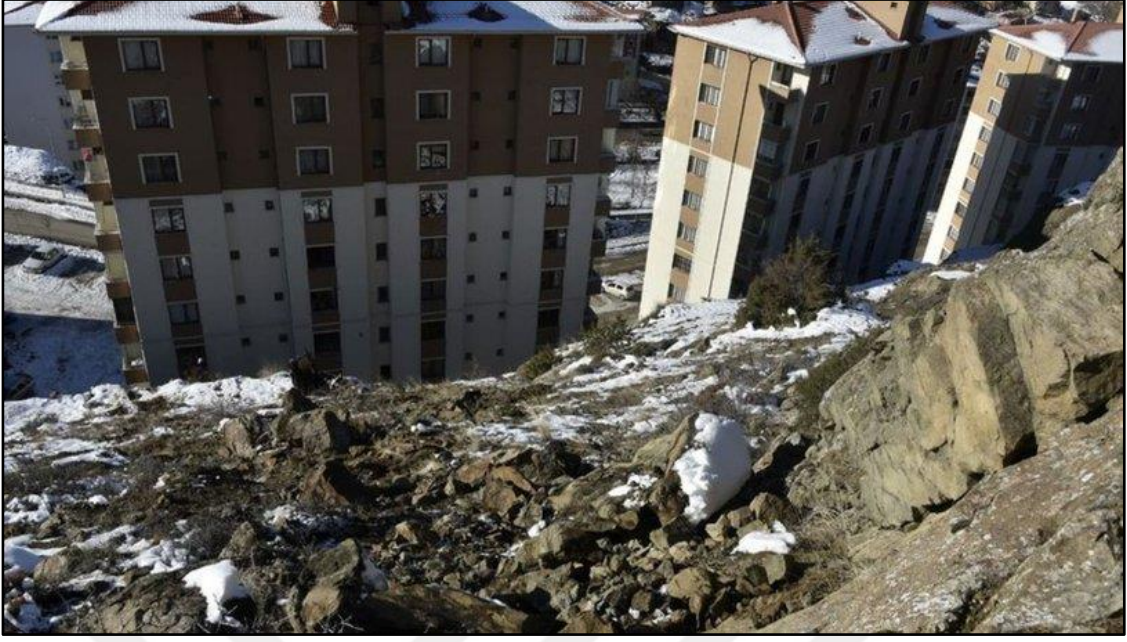
Şekil 3.10. Alibaba Formasyonu'na ait kesilmiş şevlerden kopan andezit blokları (Oltanbey Mah. Müze Evler Sitesi)
