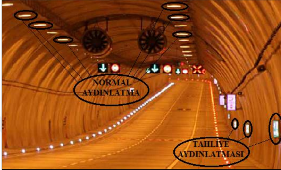
Şekil 1.7. Aydınlatma sistemi (normal ve tahliye aydınlatmaları) (URL-10, 2020).
