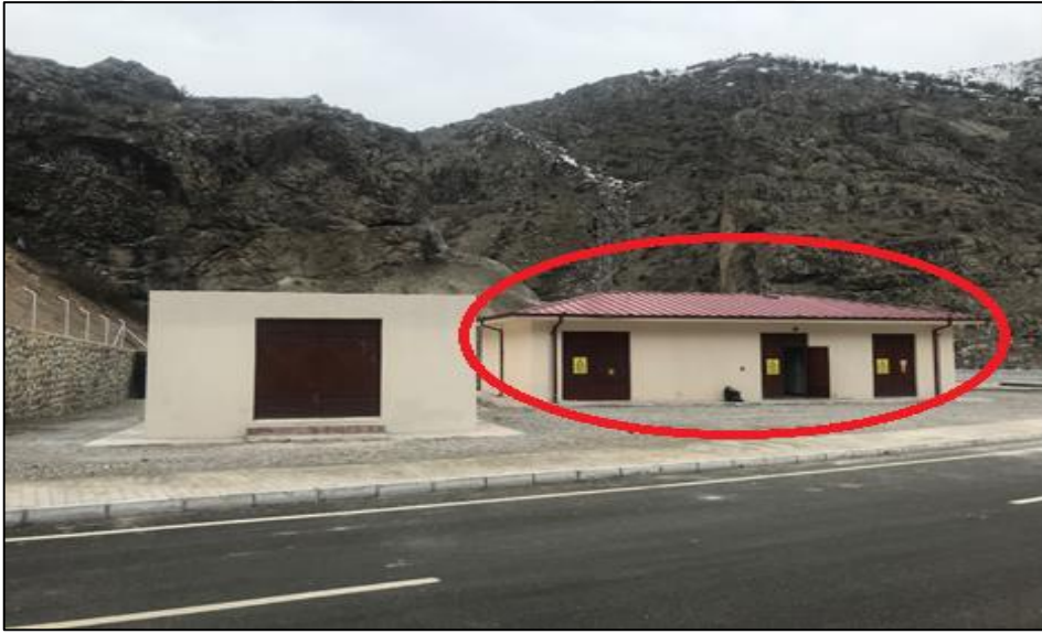
Şekil 1.14. Karayolu tüneli elektrik dağıtım binası
