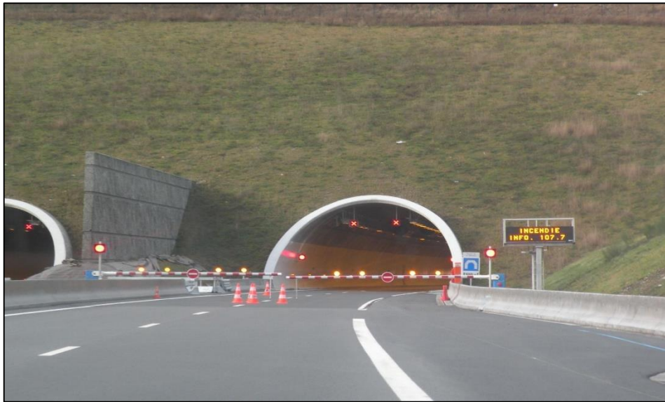
Şekil 1.28. Bariyerler ile trafiğe kapatılmış tünel (URL-18, 2020).
