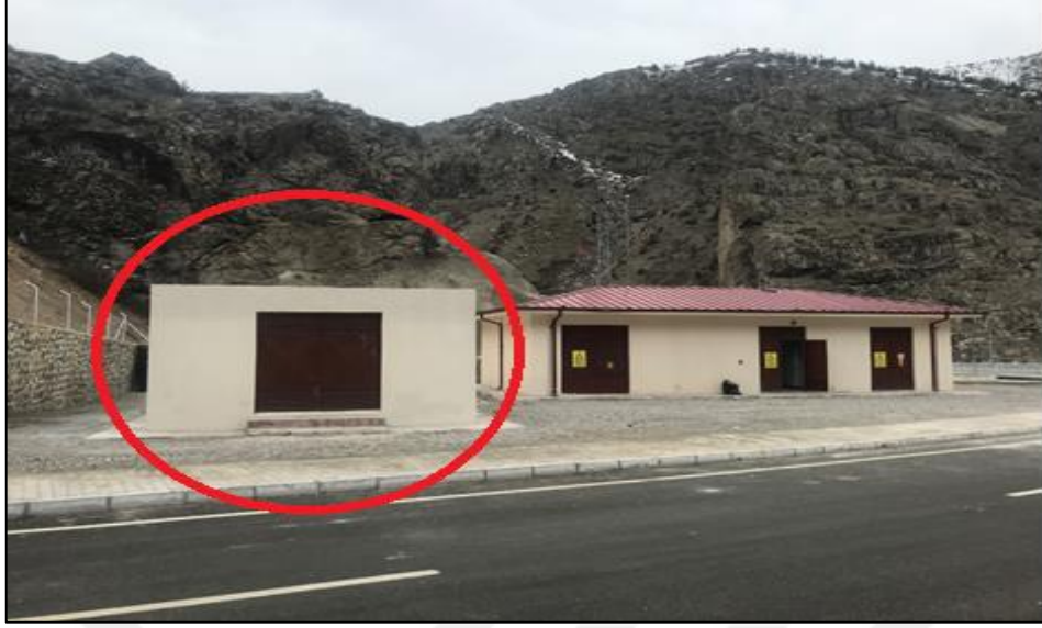
Şekil 1.10. Karayolu tüneli su deposu
