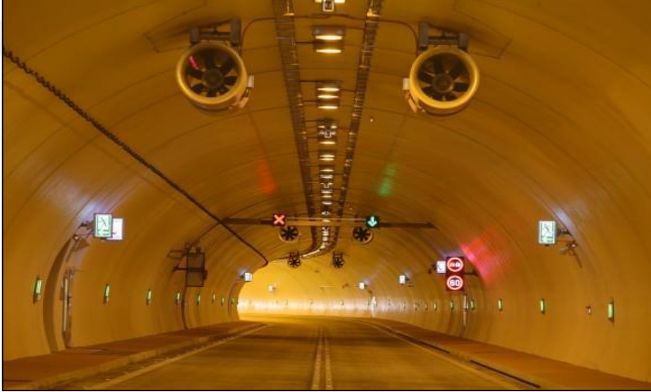
Şekil 1.8. Tünel boyuna havalandırması sistemi (URL-11, 2020).
