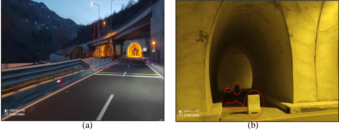
Şekil 4.1. Yeni Maçka Tünelinde New jersey ile kapalı refüj geçidi (a) ve bağlantı yolları (b)
