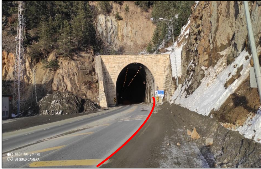
Şekil 4.2. Zigana tüneli Gümüşhane istikameti çıkış portalında bulunan kurplu kesim
