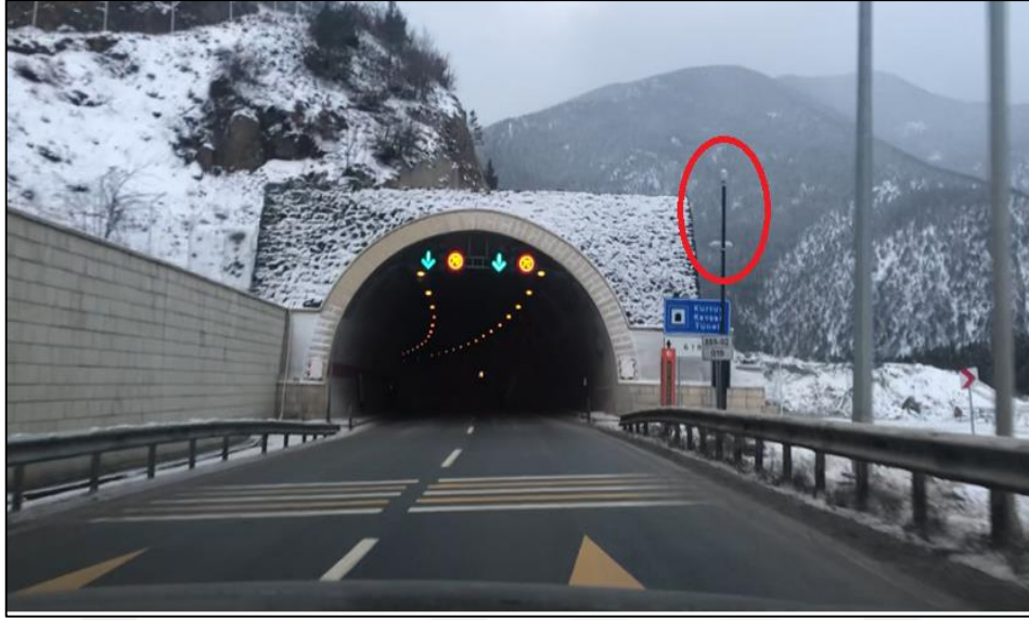
Şekil 1.27. Tünel meteoroloji istasyonu
