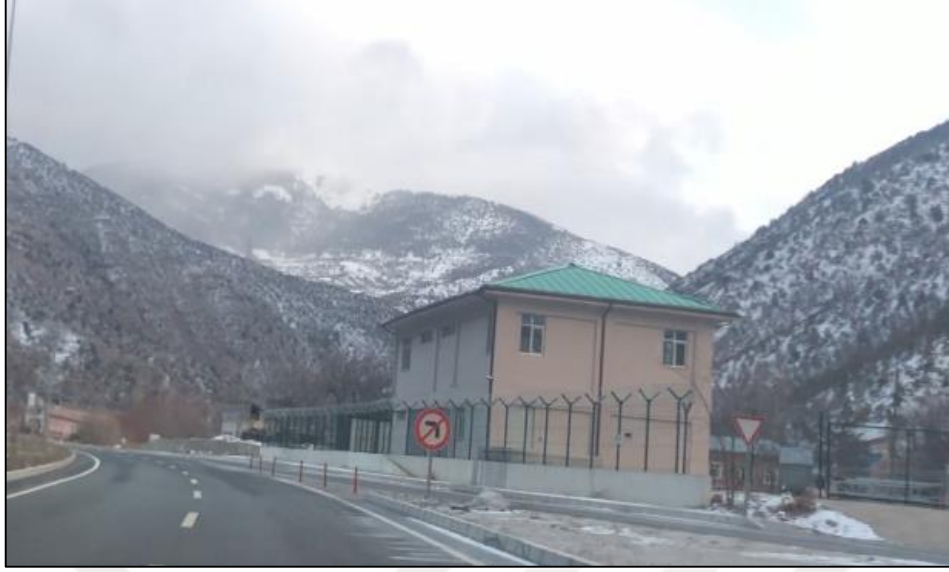
Şekil 1.11. Tünel kontrol binası
