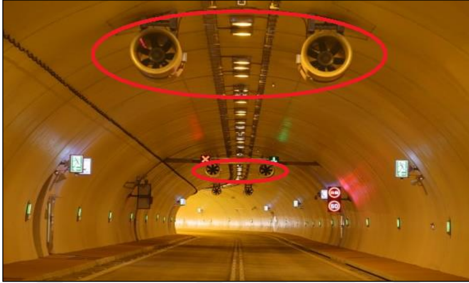
Şekil 1.19. Tünel havalandırma sistemi (URL-11, 2020).
