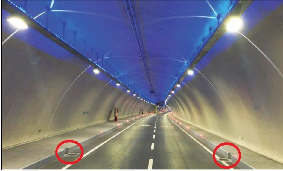
Şekil 1.6. Drenaj sistemi mazgalları (URL-9, 2020).
