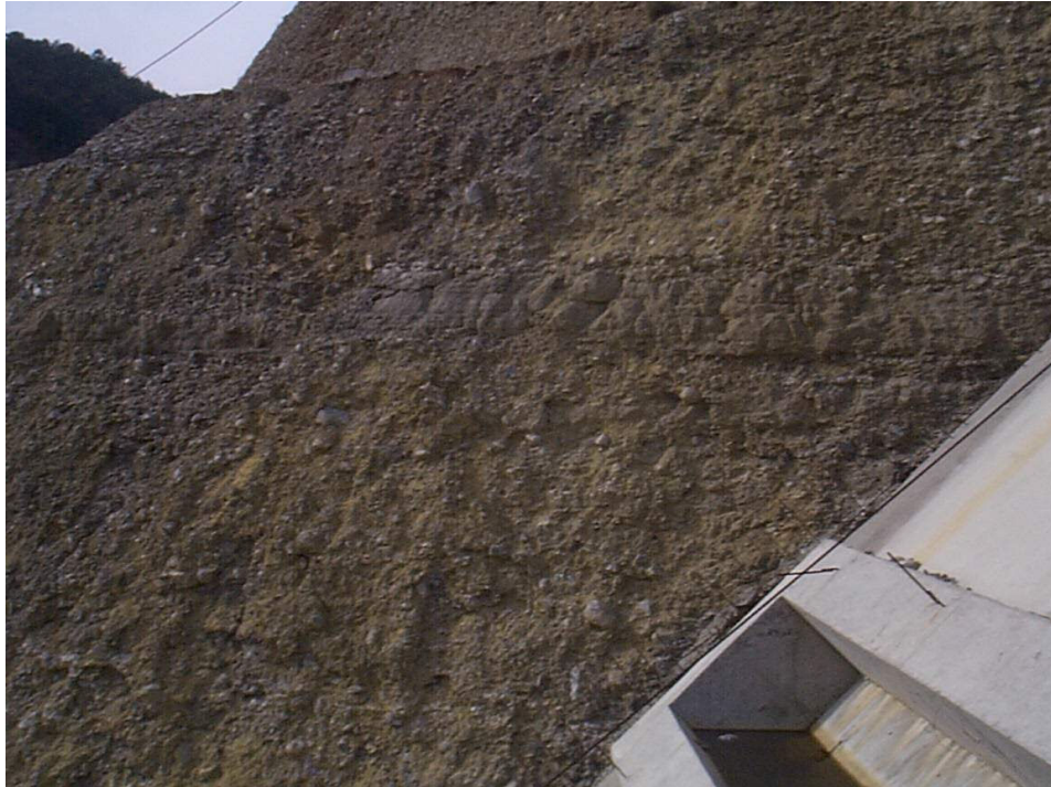
Şekil 1.2 Teras malzemesinin genel görünümü (Enerji Tüneli sağ sahil mansap şevleri)
