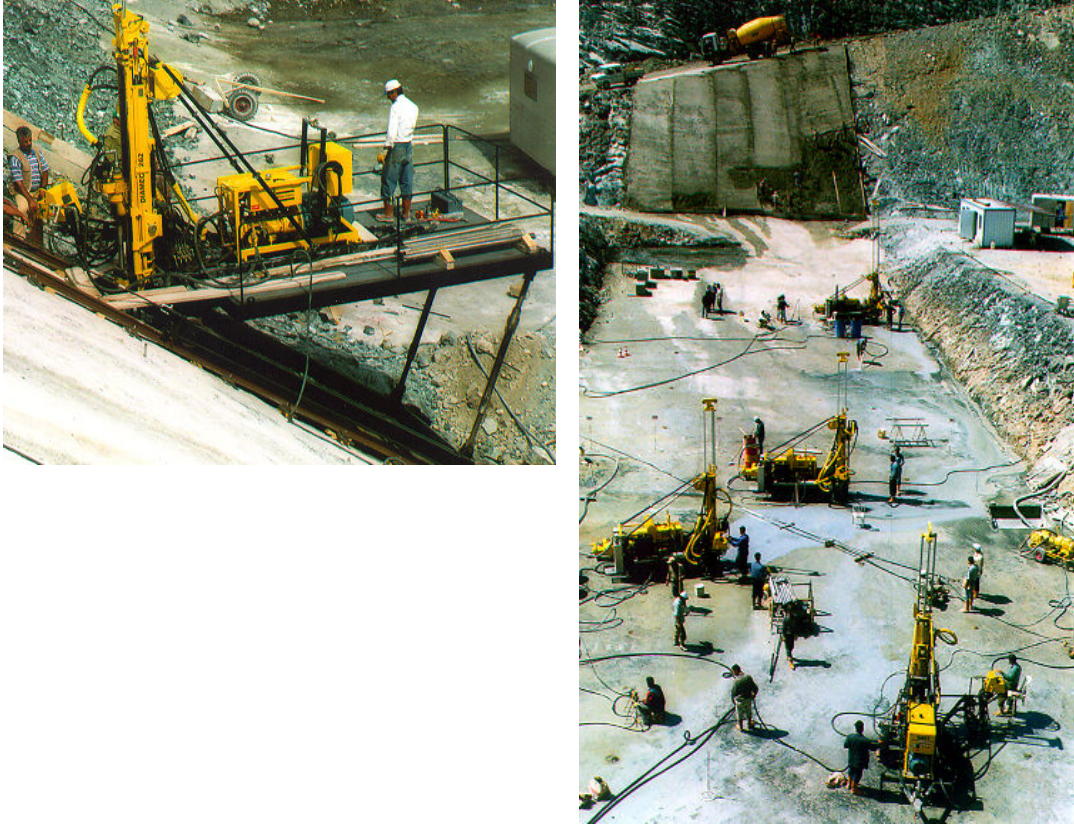
Şekil 4.2 ve 4.3 Dalaman – Akköprü barajı temel enjeksiyonu uygulamaları.
