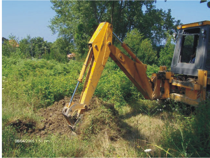
Şekil 5.3 KM 1+400 Kayma sahasında açılan araştırma çukuru çalışması.
