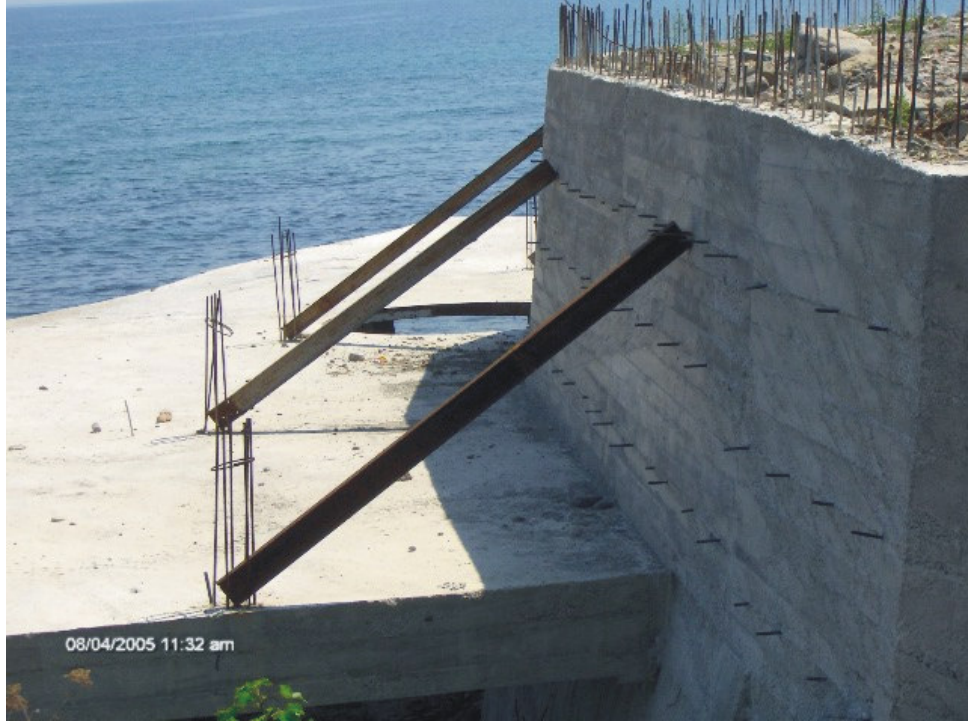
Şekil 5.1. KM1400 Kaymasına karşı kullanılan destekleme yöntemi.
