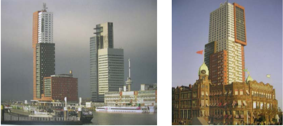
Şekil 6.34. Montevideo Rotterdam cephe görünüşleri ve kent silüetine etkisi
