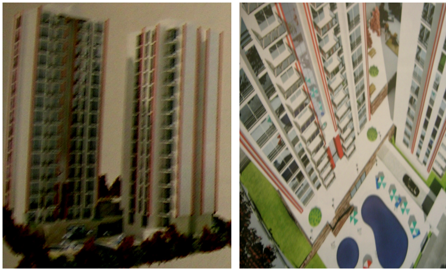
Şekil 6.75. Atapark Residence avlu ve genel görünüşü (Ünlü, 2006a)
