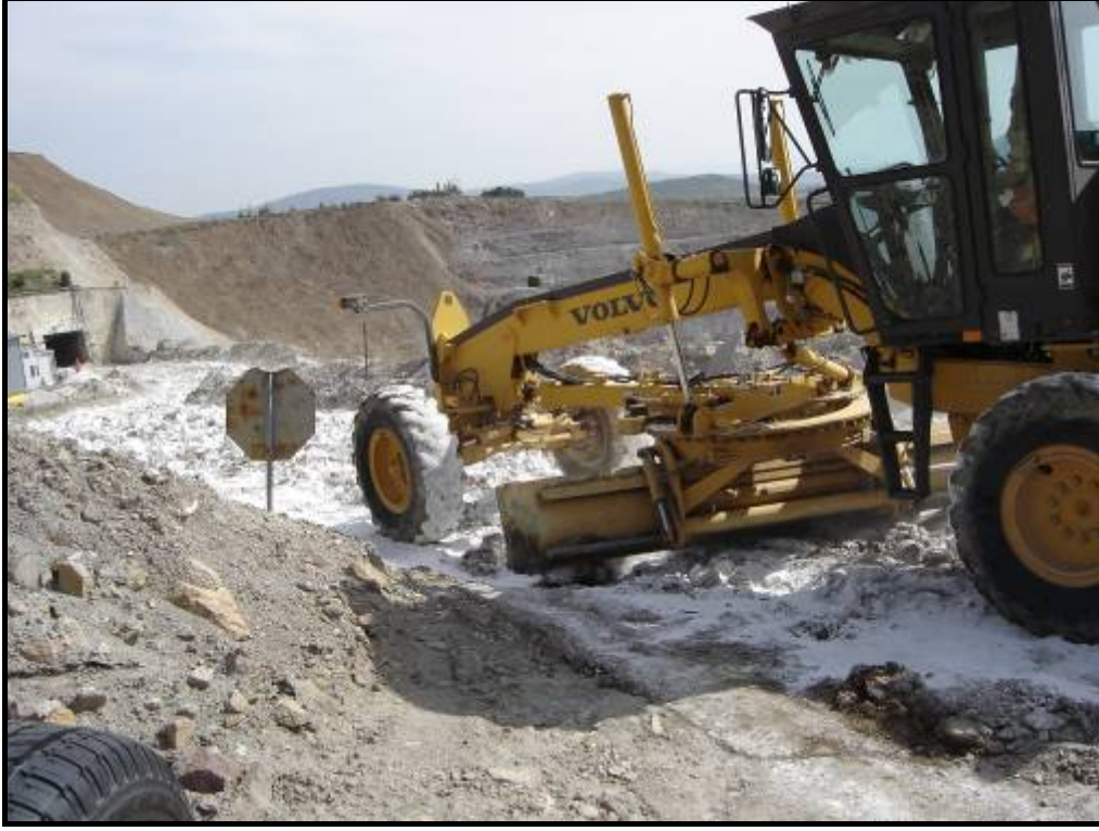
Şekil 14 Kireç ile Toprağın Greyder Vasıtası İle Karıştırılması
