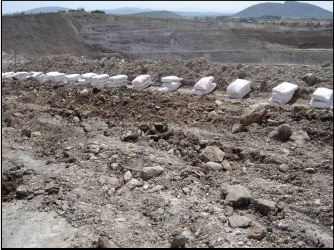
Şekil 5. Kireç Torbalarının Dizilmesi
