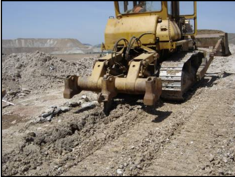
Şekil 12 Toprağın Riperlenmesi
