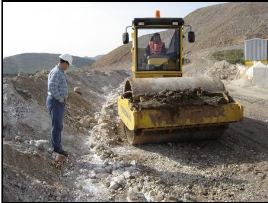
Şekil 9 Yolun Sıkılaştırılması
