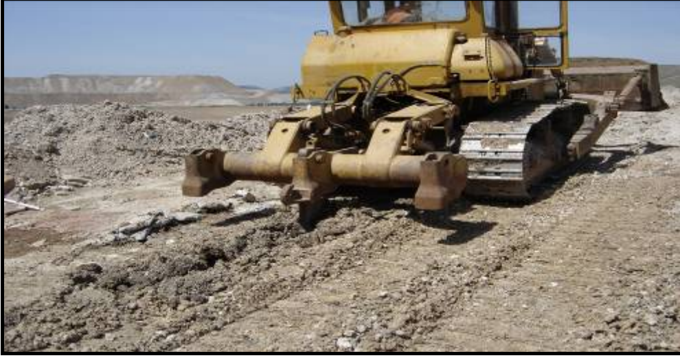
Şekil 3. Toprağın Riperlenmesi
