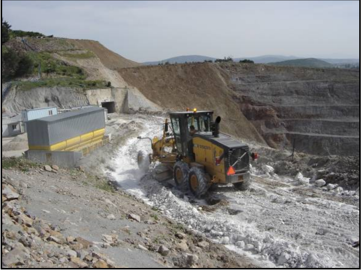
Şekil 8 Greyder ile Kireç ve Toprağın Karıştırılması
