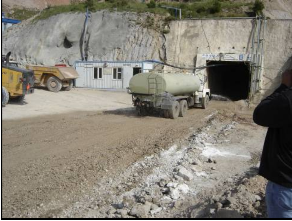
Şekil 15 Yolun Su Tankeri İle Sulanması
