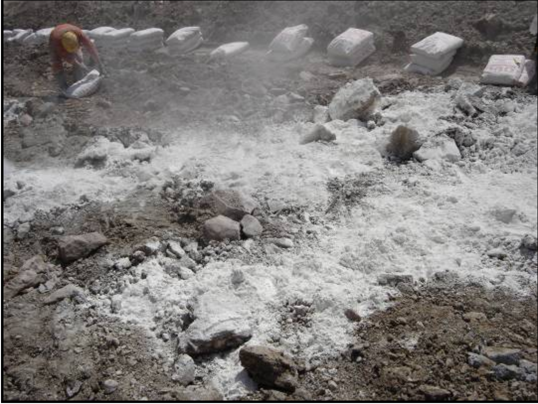
Şekil 13 Kireçin Toprağa Boşaltılması
