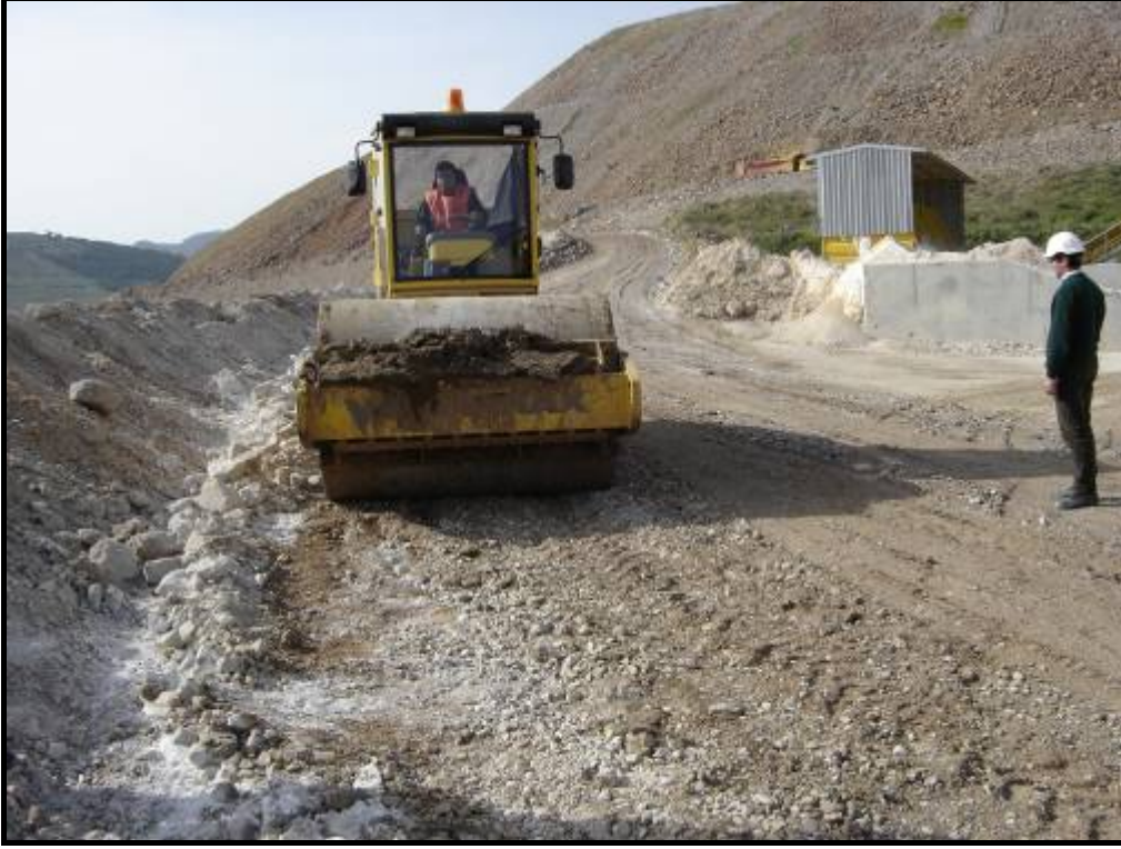
Şekil 16 Yolun Silindir ile Düzlenmesi
