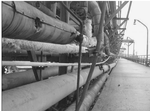
Şekil 1.4 1999 Kocaeli Depremi'nde Tüpraş rafinerisinde yangın koruma sistemleri ve tanklarda meydana gelen hasarlar (Johnson, 2003).
