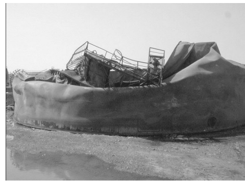
Şekil 1.4 1999 Kocaeli Depremi'nde Tüpraş rafinerisinde yangın koruma sistemleri ve tanklarda meydana gelen hasarlar (Johnson, 2003).
