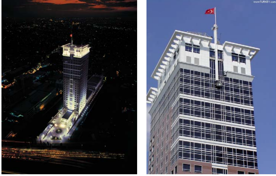
Şekil 4.10 Tefken Tower gece ve gündüz görünüşleri.
