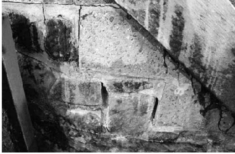
Şekil 3.1 Liman duvar basamaklarının genel görünümü. Kireç kaplamanın altından aşınarak sürüklenen sülfata dayanıklı çimento harcı (Sibbick ve diğer., 2003)
