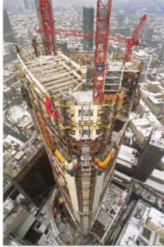
Şekil 4.42 Binanın inşaat aşamasından görünüm
