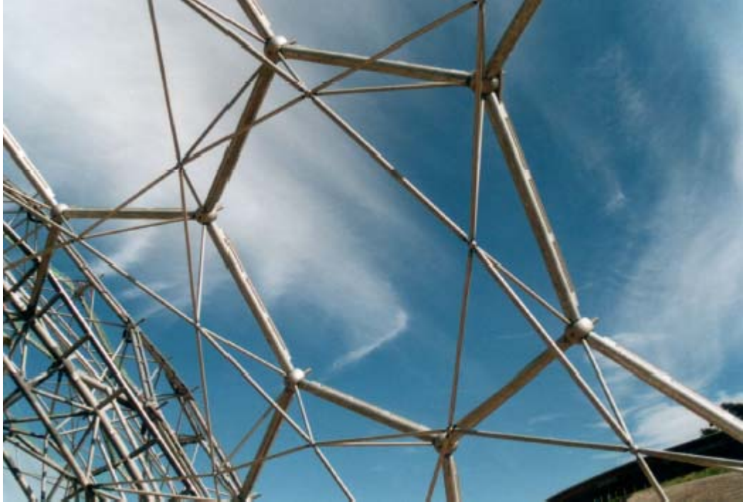
Şekil 4.50 Çift katmanlı jeodezik kubbe detayı
