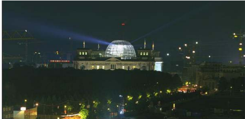
Şekil 4.19 Ters konik biçimli cisim sebebiyle gece binanın içerisinden gökyüzüne yansıyan aydınlatma sistemi
