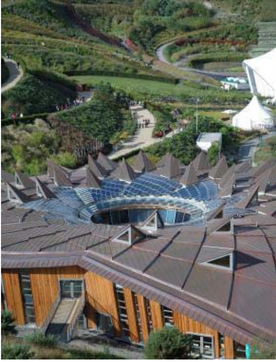
Şekil 4.56 Çekirdek binasının görünümü
