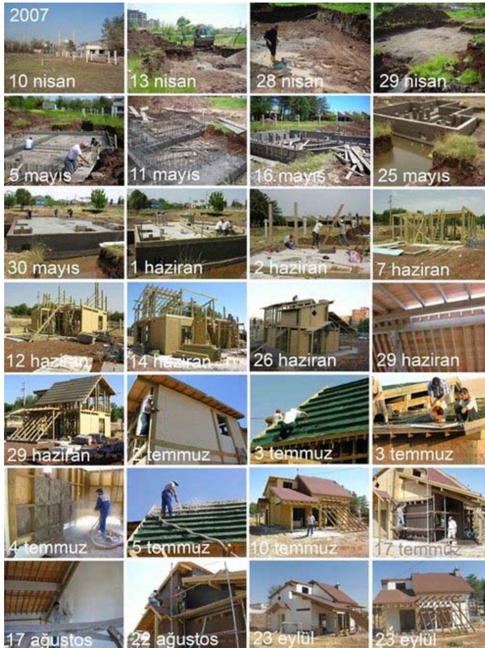
Şekil 4.90 Binanın yapım aşaması
