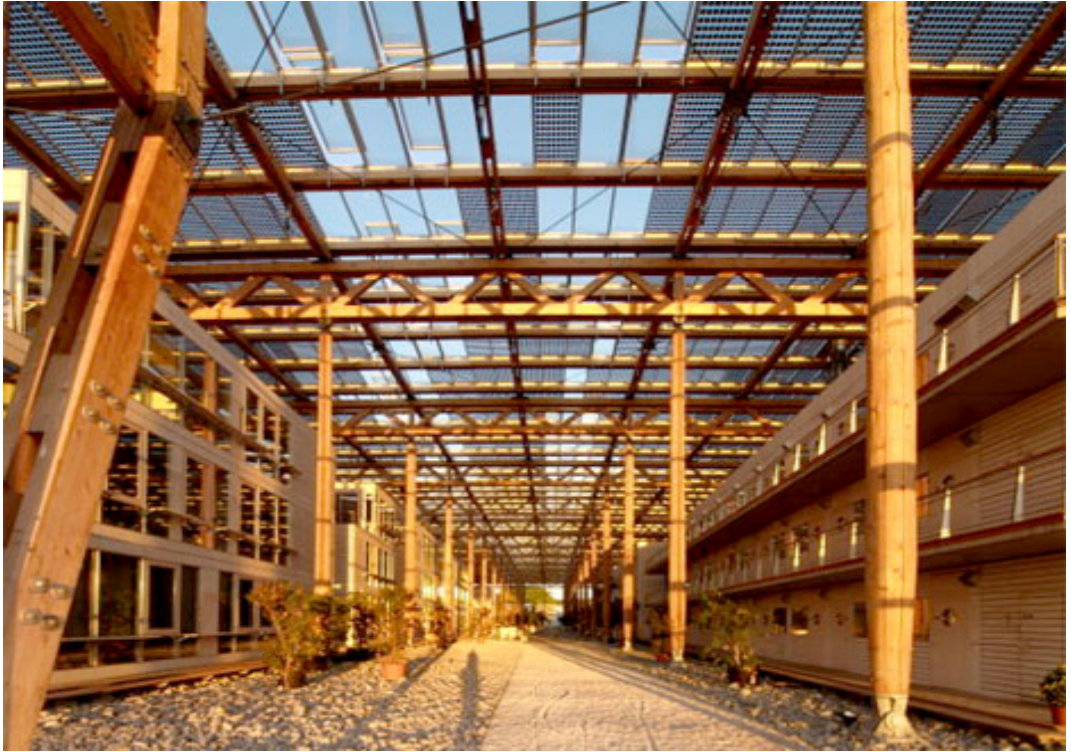
Şekil 4.78 Mont-Cenis Akademi Binasının Çatı Strüktürünün İçeriden Görünümü
