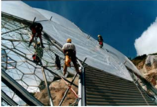
Şekil 4.55 Biomelara kaplama malzemesinin montajı
