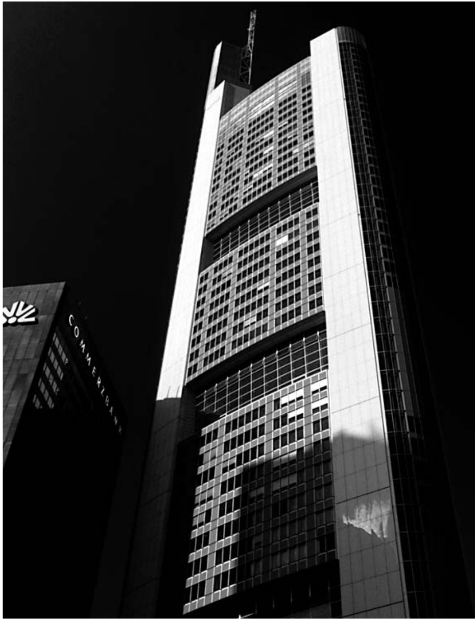
Şekil 4.43 Binanın genel görünümü
