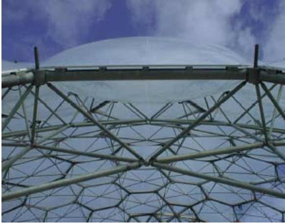
Şekil 4.53 Üç katmanlı kaplama malzemesi
