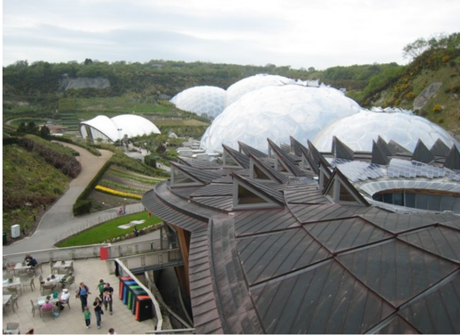
Şekil 4.57 Çekirdek binasının görünümü
