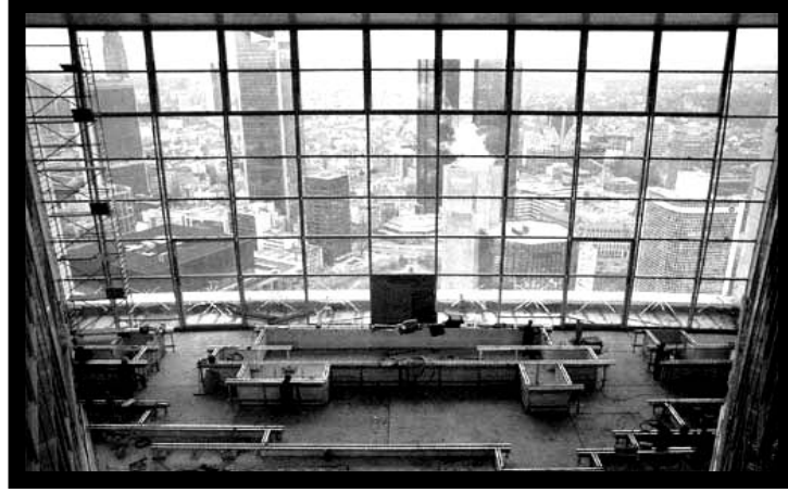
Şekil 4.36 Cepheye içeriden bir bakış
