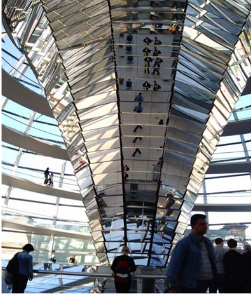
Şekil 4.18 Ters konik biçimli cismin doğal aydınlatmaya katkısı
