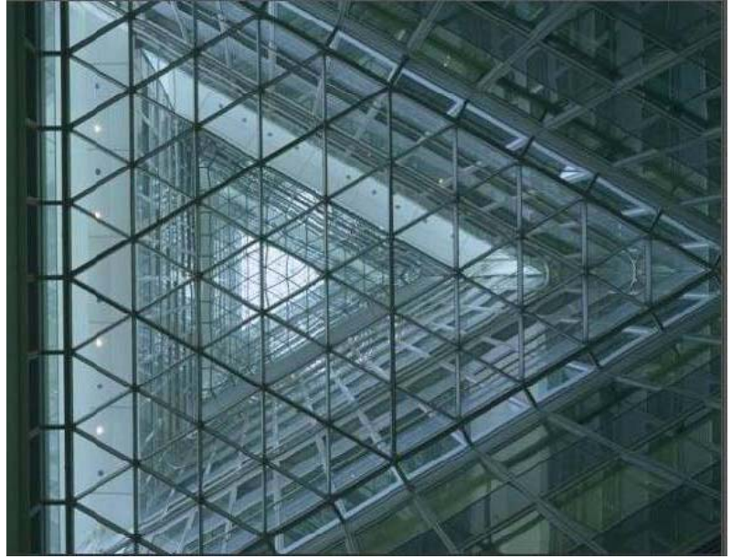
Şekil 4.31A Havalandırma için mimarın tasarım eskizi Şekil 4.31B İç mekanda havalandırmaya yardım etmesi amacıyla tasarlanmış atrium
