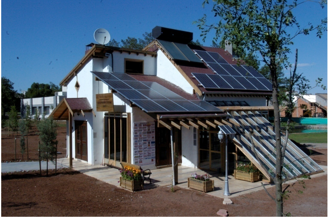
Şekil 4.89 Binanın çatısına konulan fotovoltaikler
