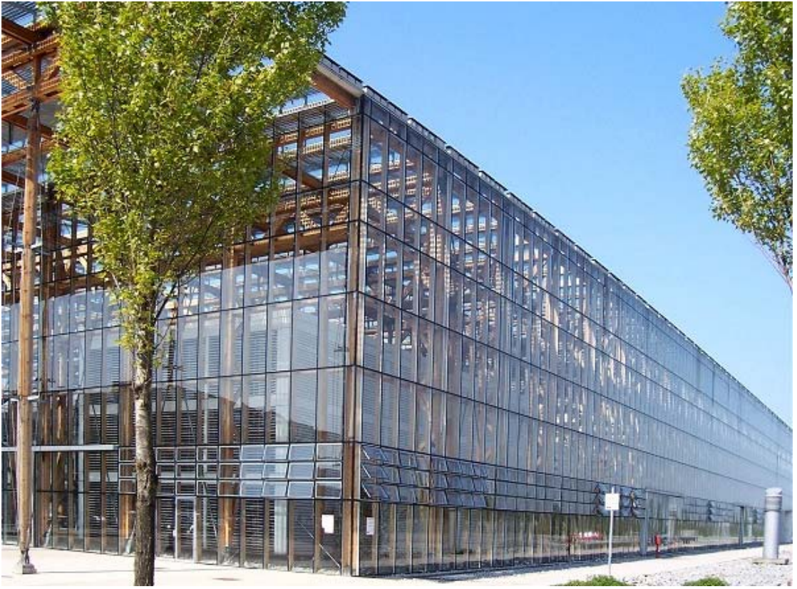
Şekil 4.84 Akademi Binasının Genel Görünüşü
