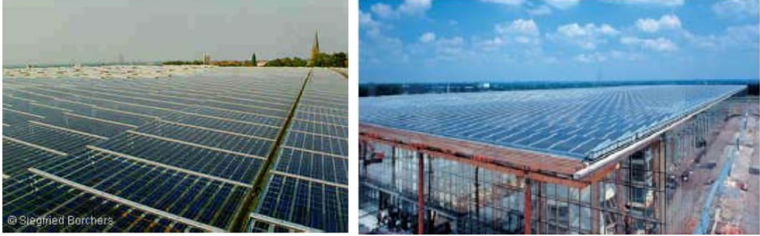
Şekil 4.79 Çatıdaki Fotovoltaiklerin Görünümü
