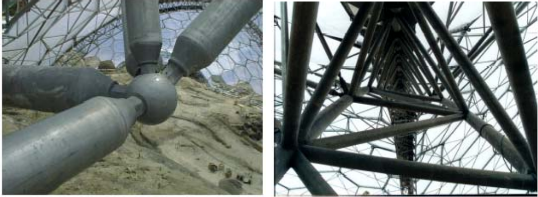
Şekil 4.60 Jeodezik kubbelerin profil birleşim detayları
