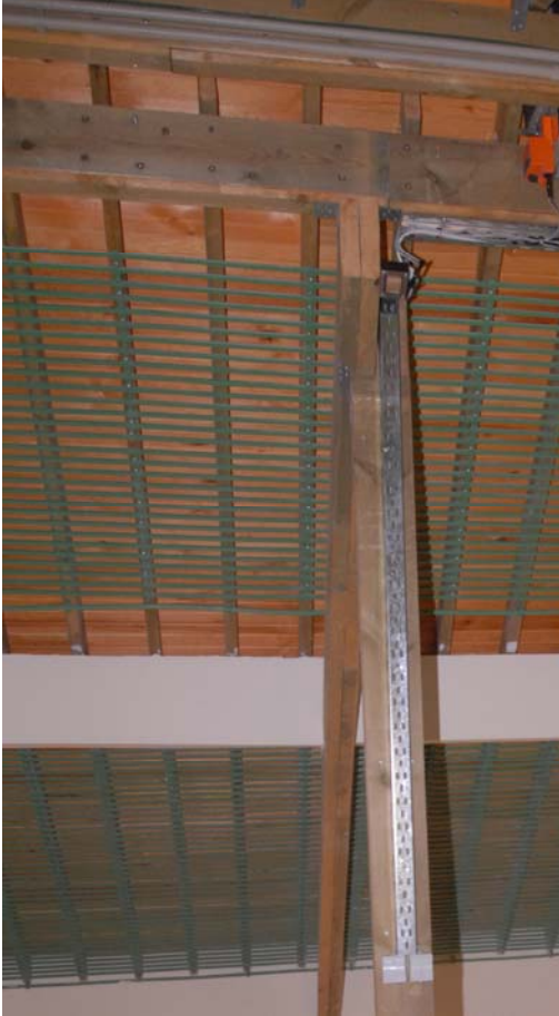
Şekil 4.91 Binada dolaşan sabit ısı boruları
