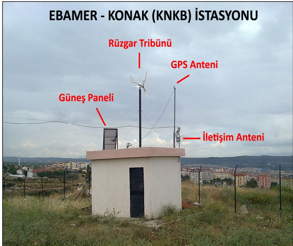
Şekil 5.12 Deprem istasyon binası ve elemanları genel gösterimi (Konak İstasyonu örneğinde).
