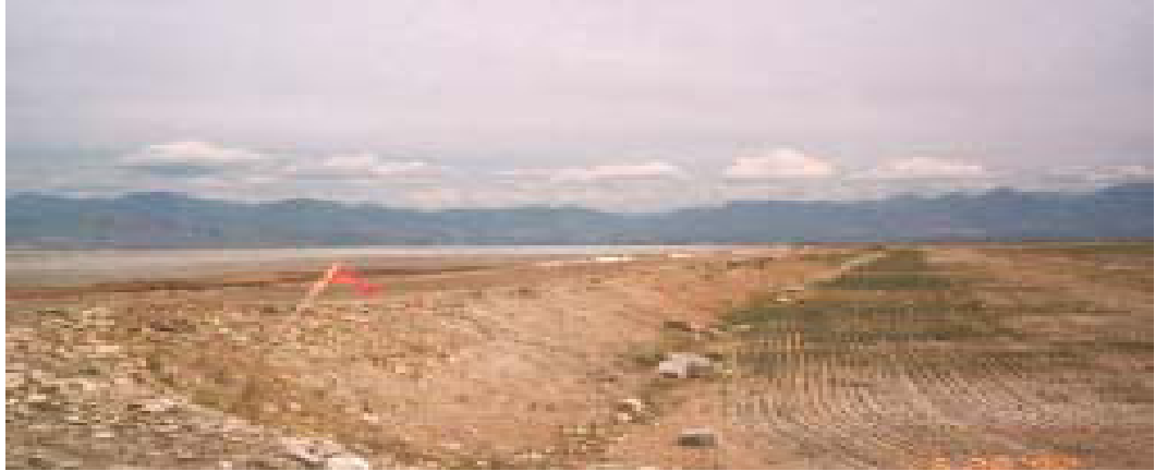
Şekil 3.7 Bent yapılarak atık yığınının izole edilmesi
