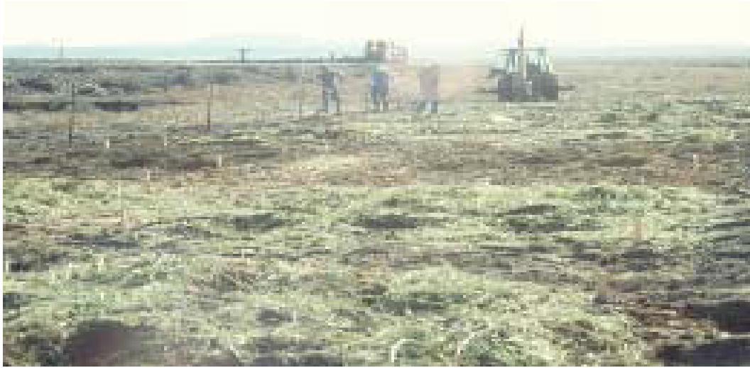
Şekil 3.11 Rekültive edilen yüzeylerde malç uygulaması
