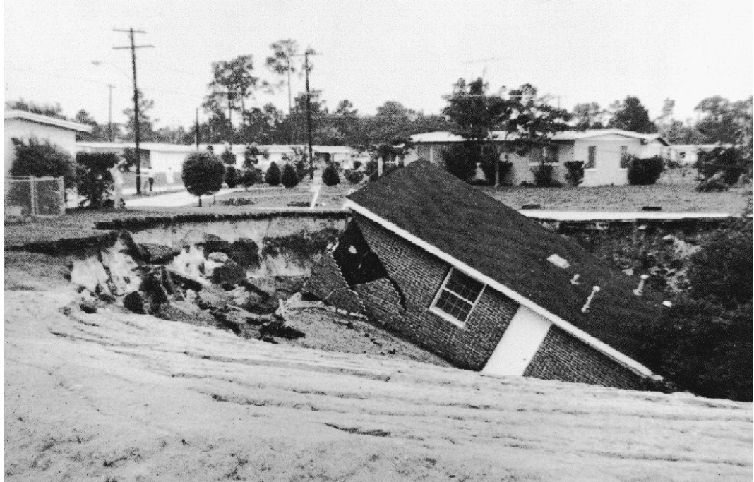
Şekil 1.1 Yerleşim yeri altındaki oluşan tasmanın etkisi
