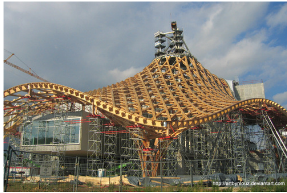
Şekil 3.23 Pompidou Metz lamine ahşap çatı kabuğu ( www.panoramio.com/photo/23762299 )
