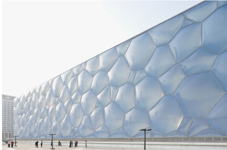
Şekil 4.40 Su Küpü -ETFE hava yastıklarıyla oluşturulan dış cephe yüzeyi
