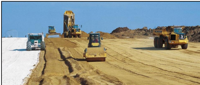
Şekil 4.15 Yolun sıkılaştırılması ve diğer çalışmalar.
