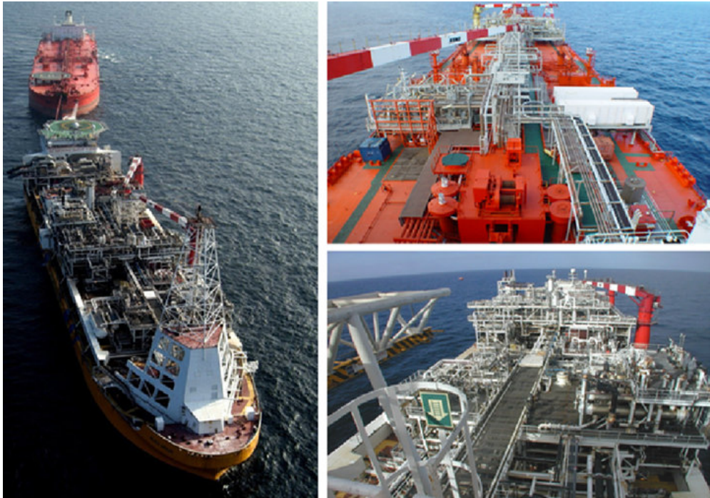
Şekil 1.15 FPSO yapılarında güverte üstü boru hatları
